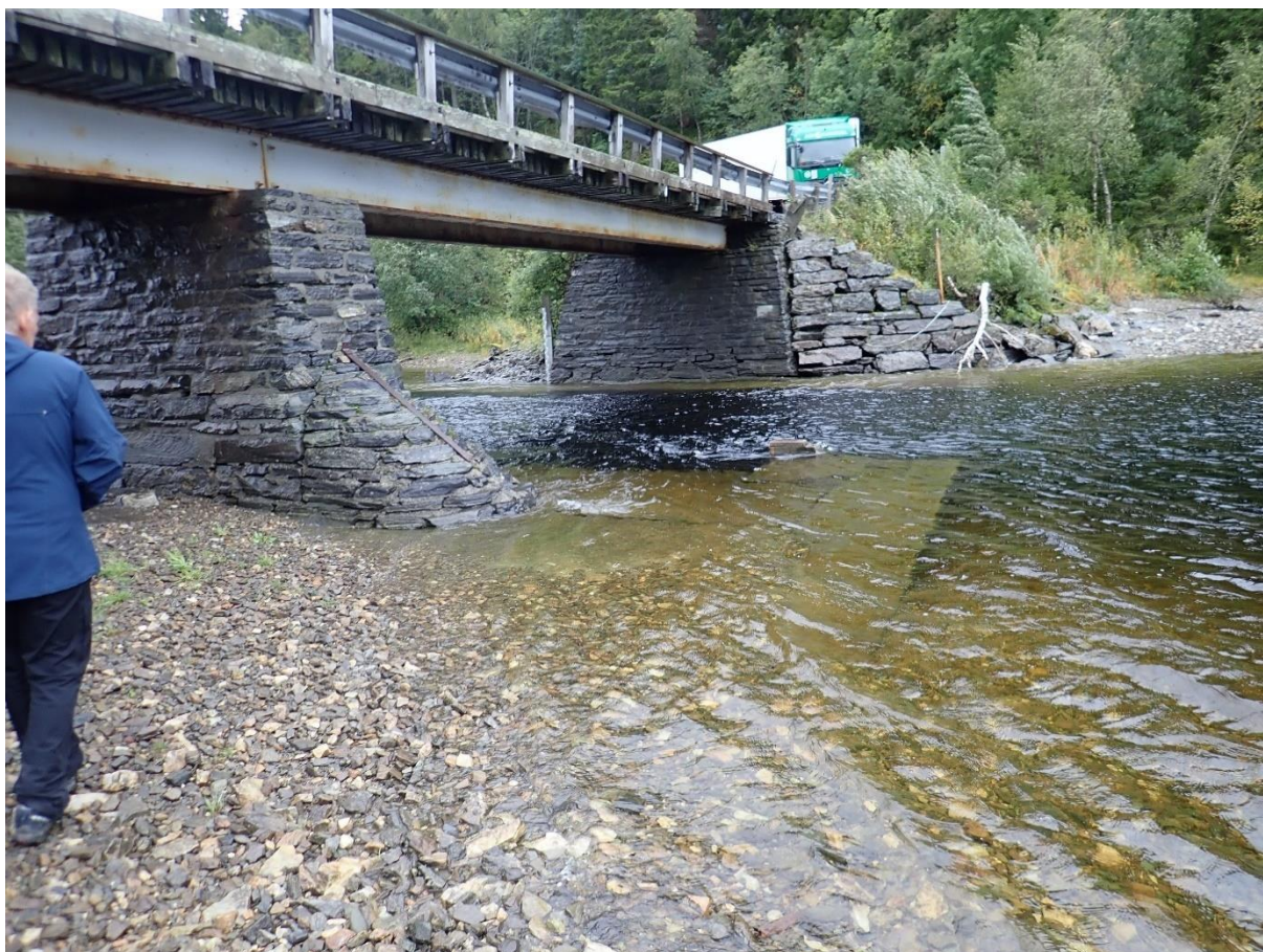
Figur 5. Foto (fra NVEs befaring 07.09.2021) viser Osbrua sett fra nord. Dammen ligger ca. 1 km lenger øst for brua. Det er sprengt en kanal gjennom en bergterskel ved brua. Vannet strømmer fra høyre mot venstre på fotoet.
