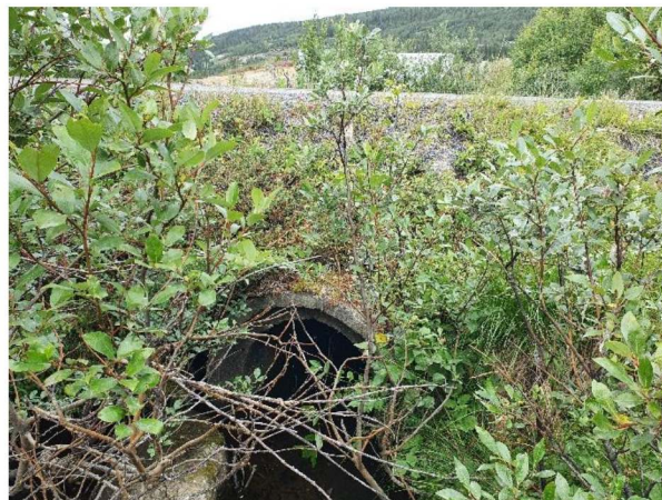
Figur 10: Stikkrenna til bekk vest under Murkelivegen.
