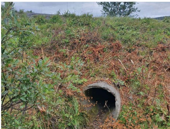
Figur 9: Stikkrenna til bekk vest under Panoramavegen.
