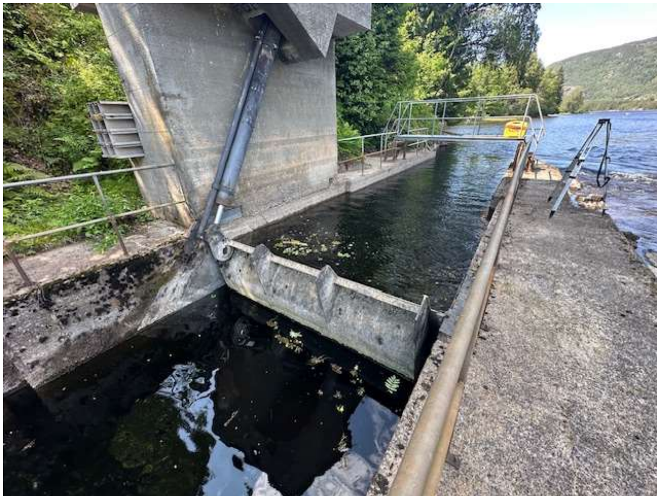
Figur 2-5 Luke sett motstrøms (Bilde: Skagerak Kraft AS)
