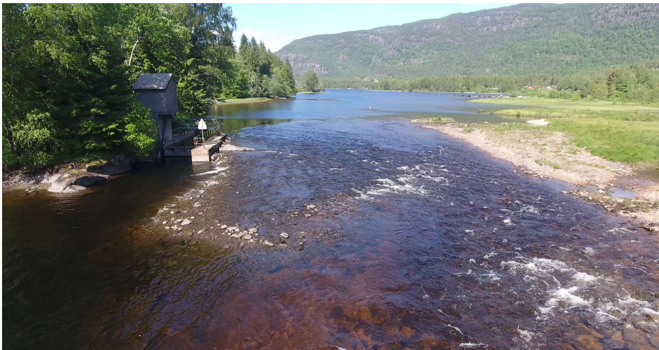
Figur 1-2 Utløp Seljordvatn, sett motstrøms. Lukekonstruksjon til venstre og naturlig terskel til høyre. (Bilde: Skagerak Kraft AS)
