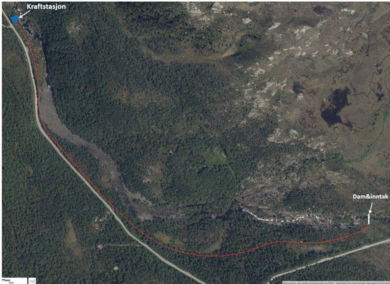
Figur 3-9 Oversiktsbilde av vannvei i terrenget.
