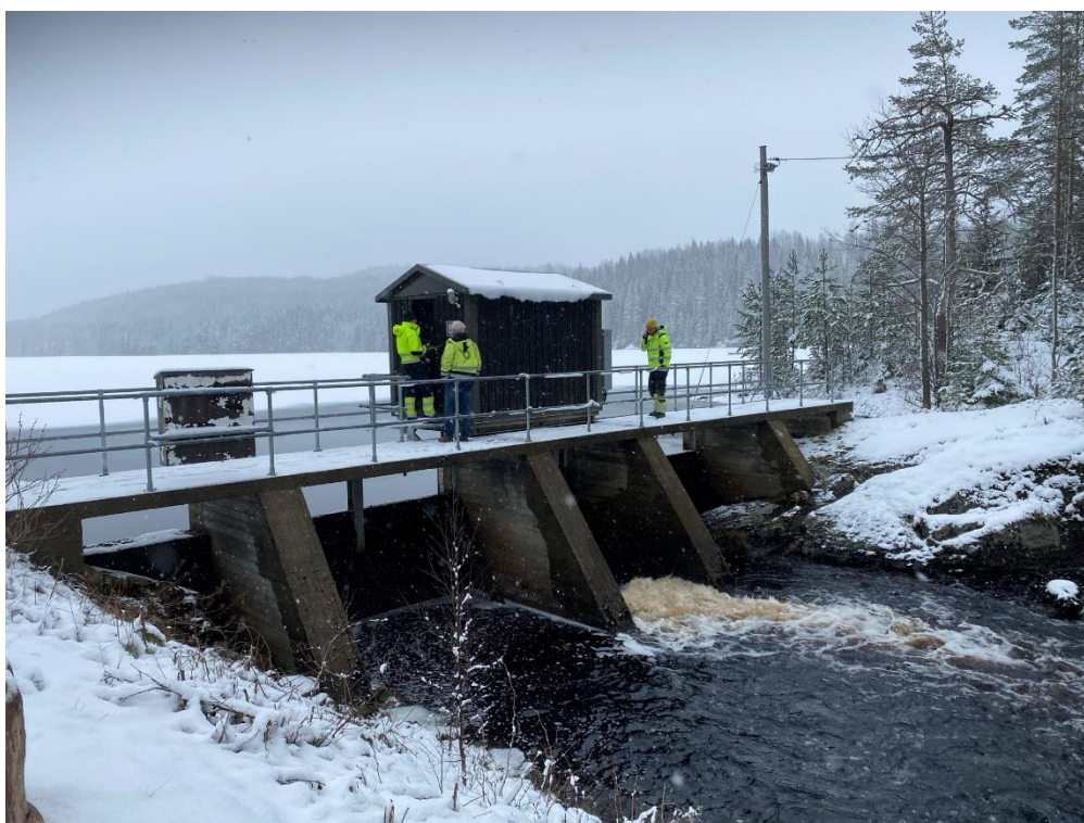
Figur 2 Dam Øyersjøen (Vikerdammen). Det er fire store felt (totalt > 4m bredde) i dammen med overløp på kote 270,30.
