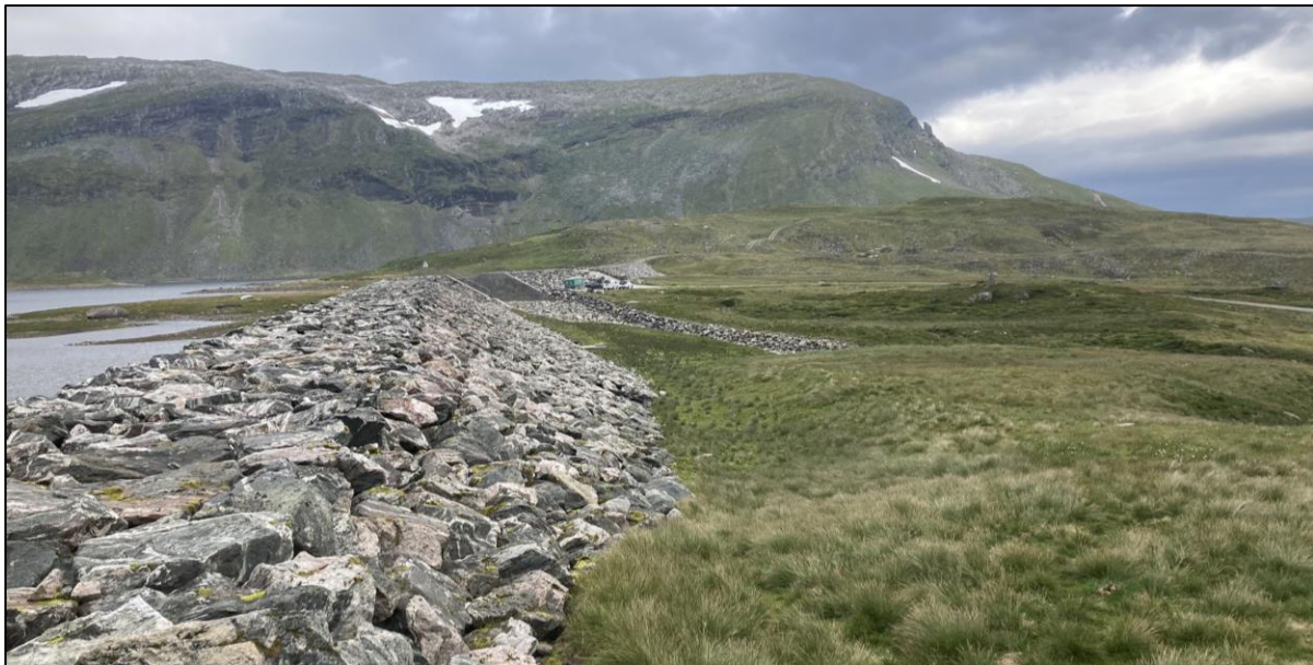
Figur 3-1. Dam Årebotn nedstrøms, sett fra damkrona mot vest. Foto: Sweco Norge, 2022.
