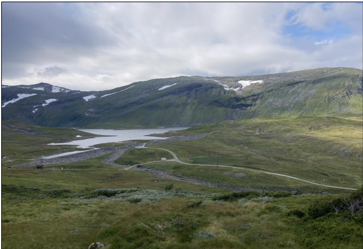
Figur 3-5. Oversiktsbilde over dammens beliggenhet med anleggsvei i terrenget helt frem til dammen, og utløpskanal ved dammens østre side. Foto: Sweco Norge, 2022.
