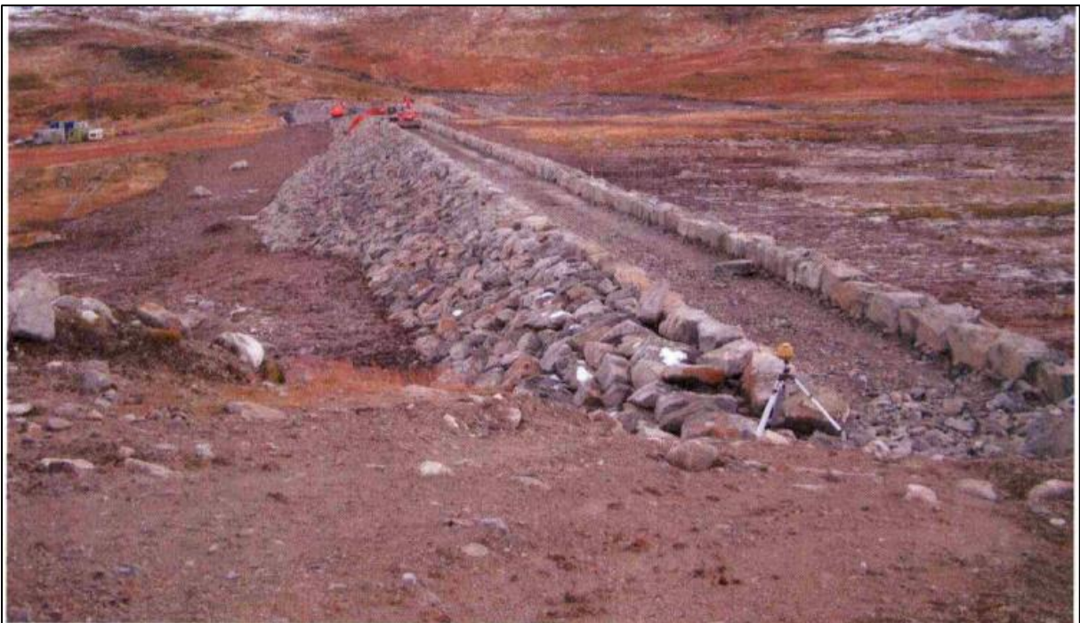
07.10.2003. Dam sett frå vestsida.
