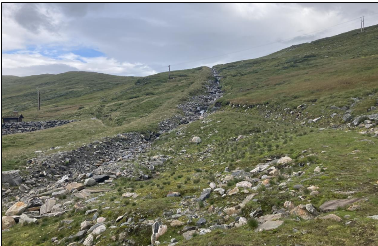
Figur 2-17: Oversiktsbilde tatt mot nordøst av kanalløpet med utløp i Åretbotn. Foto: Sweco Norge, 2022.
