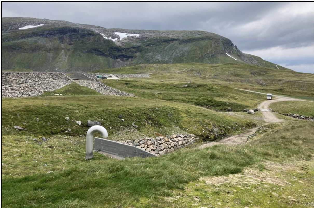
Figur 2-16. Landskapet nedenfor dammen er preget av konstruksjoner tilknyttet damanlegget og adkomst og anleggsveier. Revegetering av arealer med tidligere inngrep har ført til at landskapet i mindre grad er påvirket. Foto: Sweco Norge, 2022.
