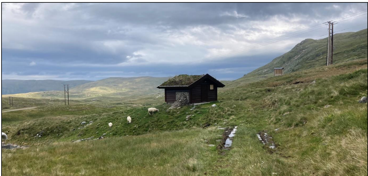
Figur 2-20. Sau på utmarksbeite i området omkring dammen. Bilde tatt med utsikt mot nord, øst for dammen. Damhytta i forgrunnen, og adkomstvei frem til dammen til venstre i bildet. Foto: Sweco Norge, 2022.
