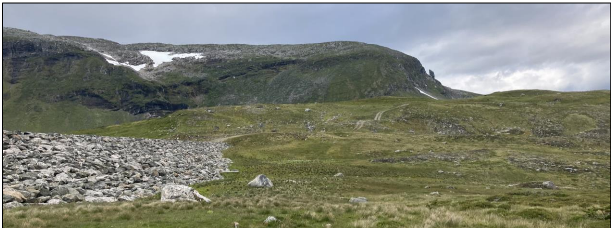
Figur 3-7. Tydelige kjørespor synes i terrenget mellom dammen og vestover mot dammens lukehus. Foto: Sweco Norge, 2022.
