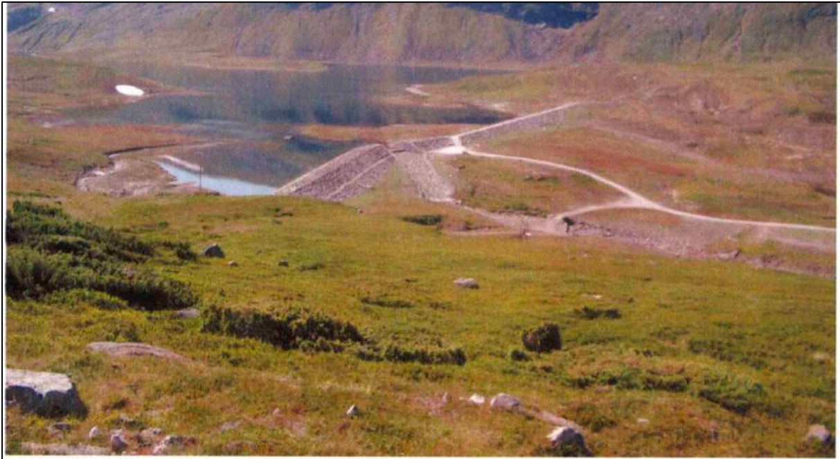
11.08.2004. Oversikt ferdig anlegg
