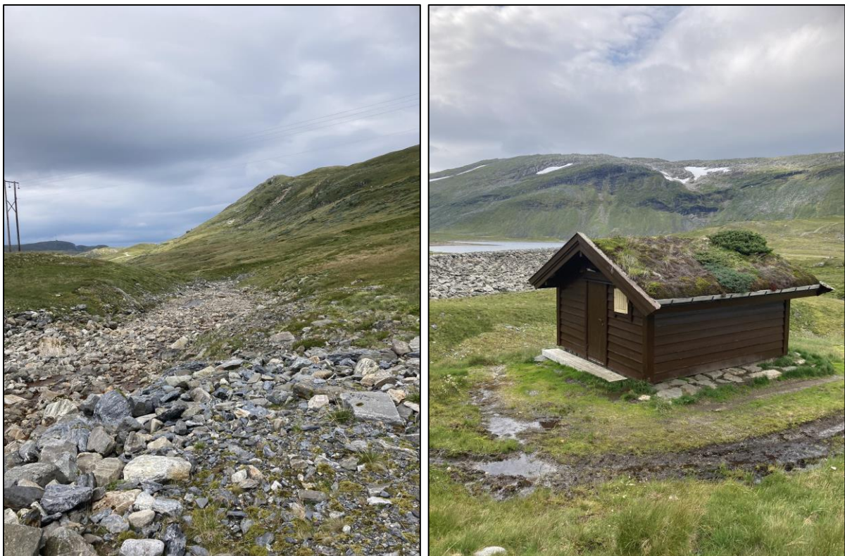
Figur 3-4. Bilde til venstre viser nedre del flom/avløpskanalen nedenfor dammen, nærmere dammen er steinen plastret langs løpet. Bilde til høyre viser damhytta, ved dammens østre side og Årebotnvatnet i bakgrunnen. Foto: Sweco Norge, 2022.
