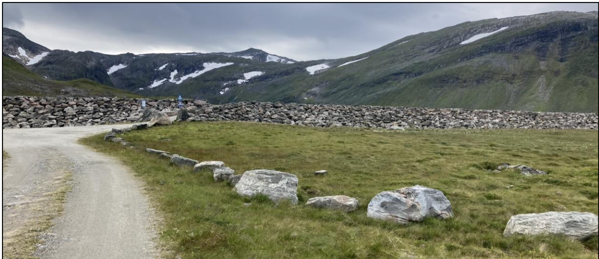
Figur 3-6. Adkomstveien frem til dammen er i god stand. Stein er lagt ut i terrenget langs veien ved dammen for å hindre uønsket privat kjøring i terrenget nedenfor dammen. Foto: Sweco Norge, 2022.
