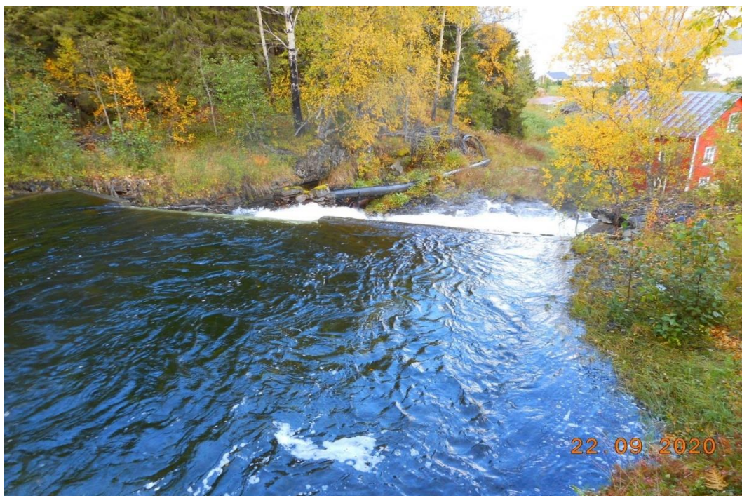
Figur 2: Bilde tatt ca. 15 m oppstrøms dam.
