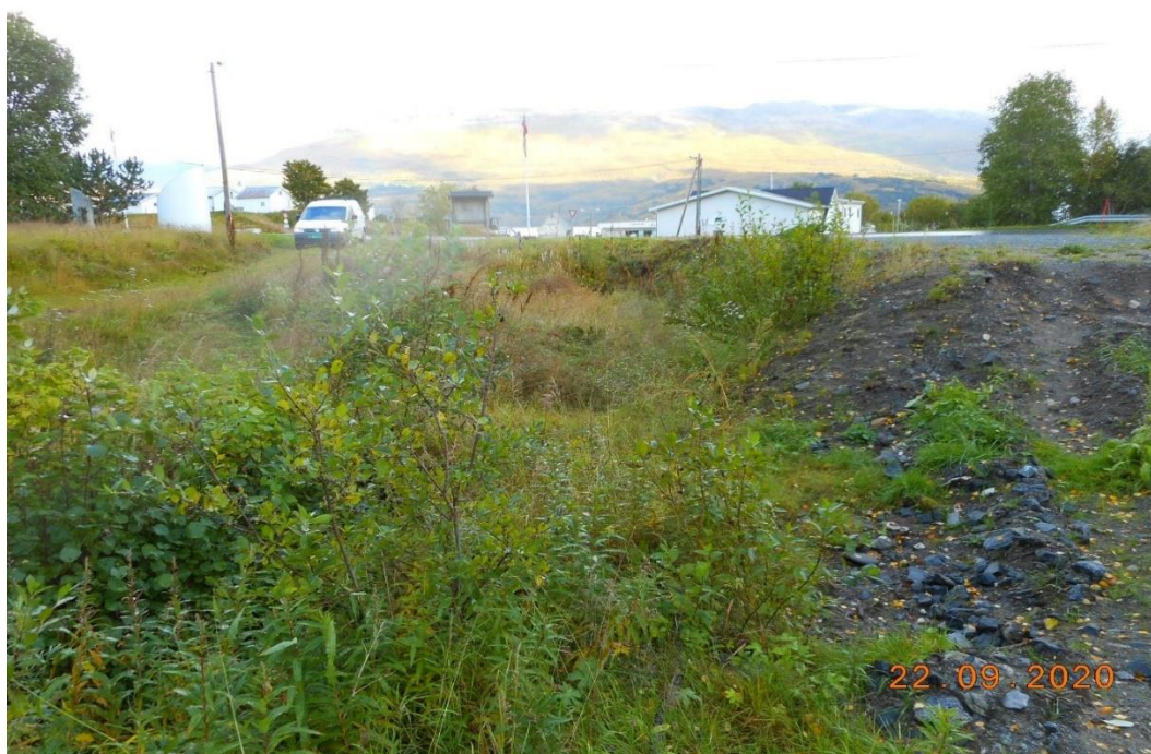
Figur 8: Flomvoll med rør for overflatevann (røret kan skimtes i det mørke feltet til høyre fra bilen). Konstruert av Gratangen kommune.
