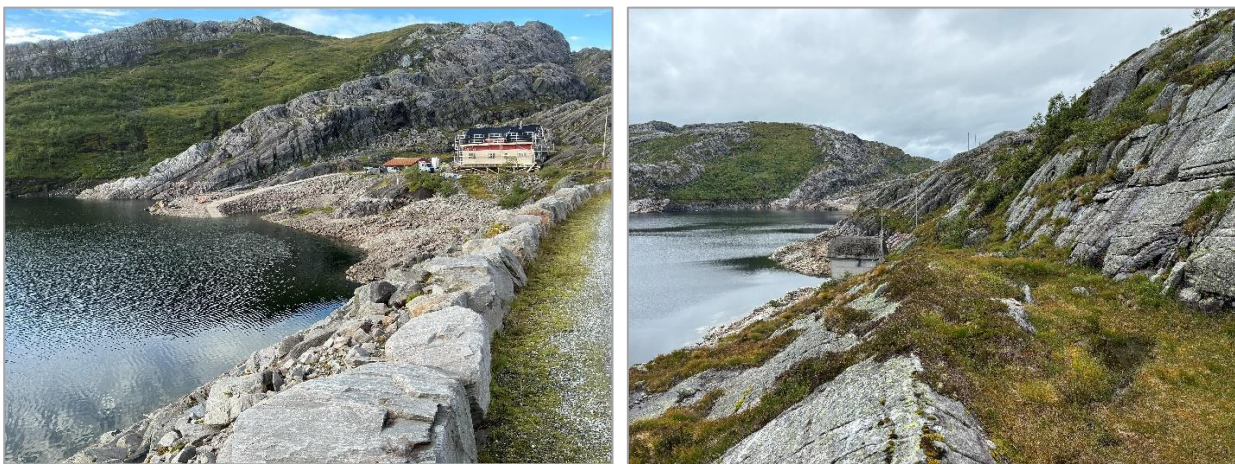
Figur 4-1. Bilder fra tiltaksområdet ved Svartavatnet. Venstre: Fra dammen mot planlagt riggområde sør for dammen. Høyre: Ved planlagt inntak og lukehus. Foto: Sweco
