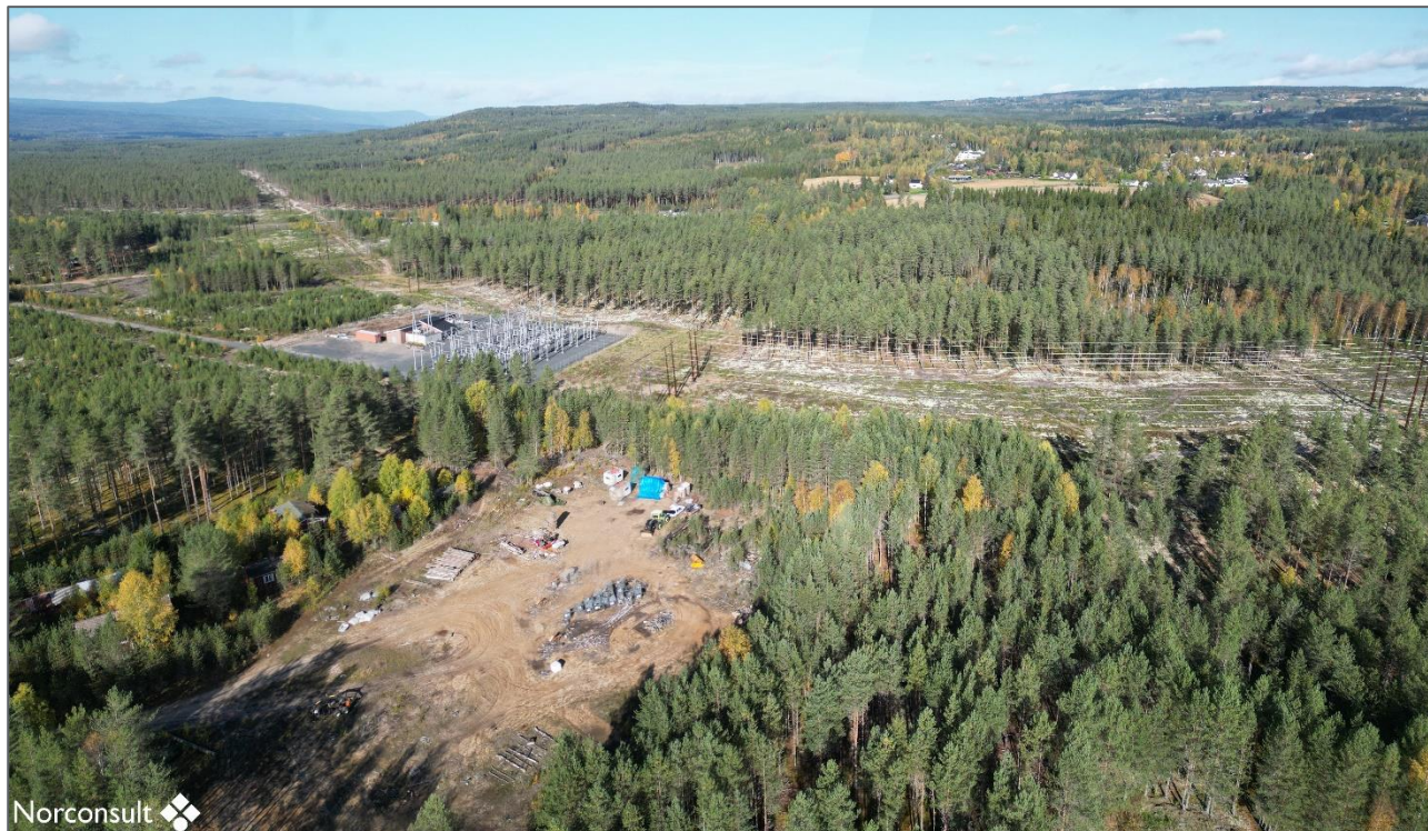
Figur 5-37: Før-bilde ned mot tiltaksområdet i vest tatt med drone.
