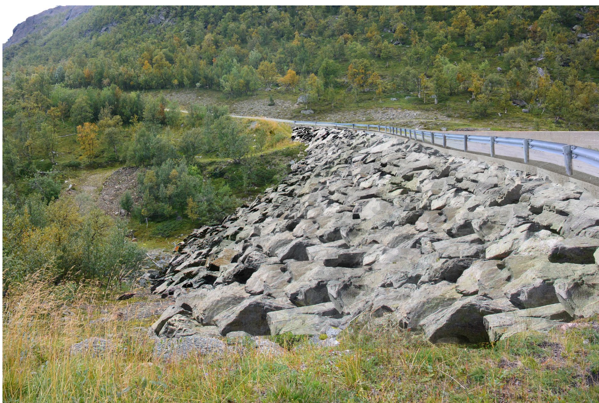
Figur 3-8. Småvatna sperredam i dag i øverst bildet, og dammen etter rehabilitering nedenfor.
