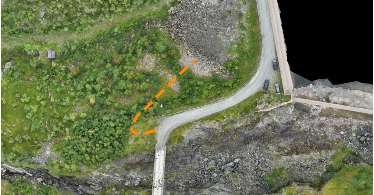
Figur 3-13. Ortofoto som viser skråningen nedstrøms hoveddammen. Skråningen er bygget opp av en del tippmateriale i svært bratt terreng.
