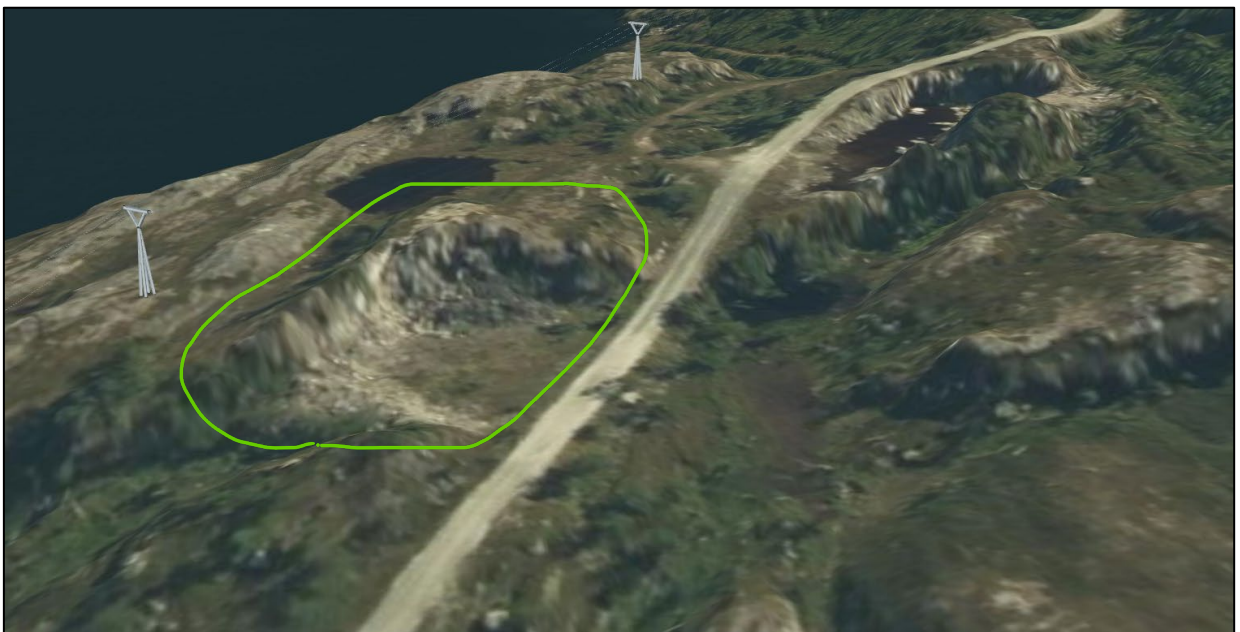
Figur 3-29. Eksisterende Masseuttak 2, merket med grønn. Eksisterende Masseuttak 1 er synlig langs veien til høyre. (Kilde: 3D.kommunekart.no)
