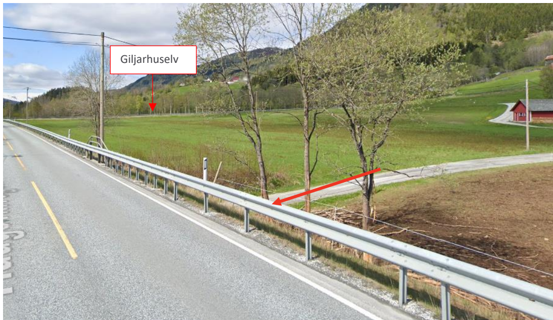
Figur 2.30 Undergang under E16 sett mot retning Haugsvik (Google maps 2023)
