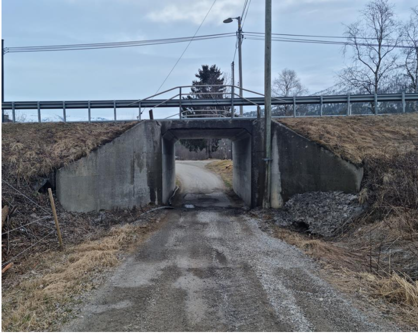
Figur 2.6 Bilde av undergang, ca. profil 1210 (SVV)
