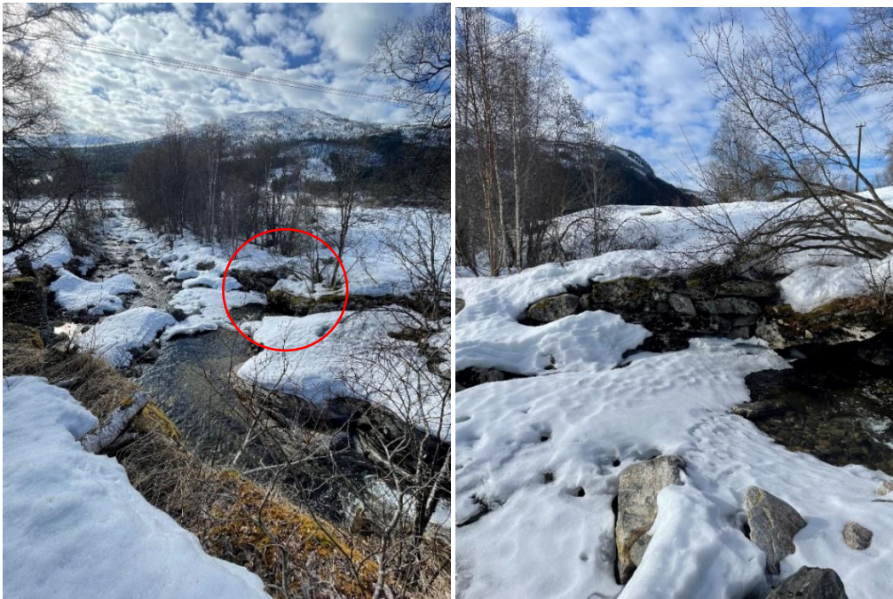
Figur 2.33 Oversiktsbilde av elveløpet ved gammel mur markert i rødt (t.v.) og bilde av mur (t.h.) (SVV)
