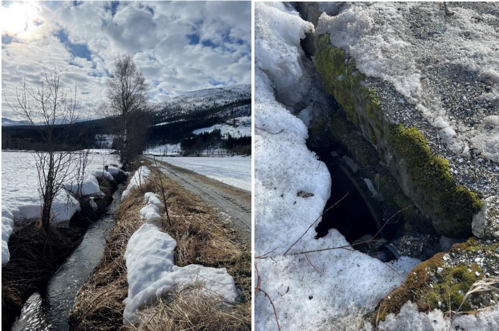
Figur 2.29 Bekk vest for Giljarhuselv (t.v.) og stikkrenne \varnothing 600 lengst vest under E16 (t.h.) (SVV)
