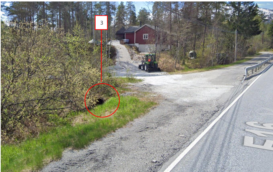
Figur 2.47 Bilde av lavbrekk 3 med stikkrenne/rør (Google maps, mai 2023)
