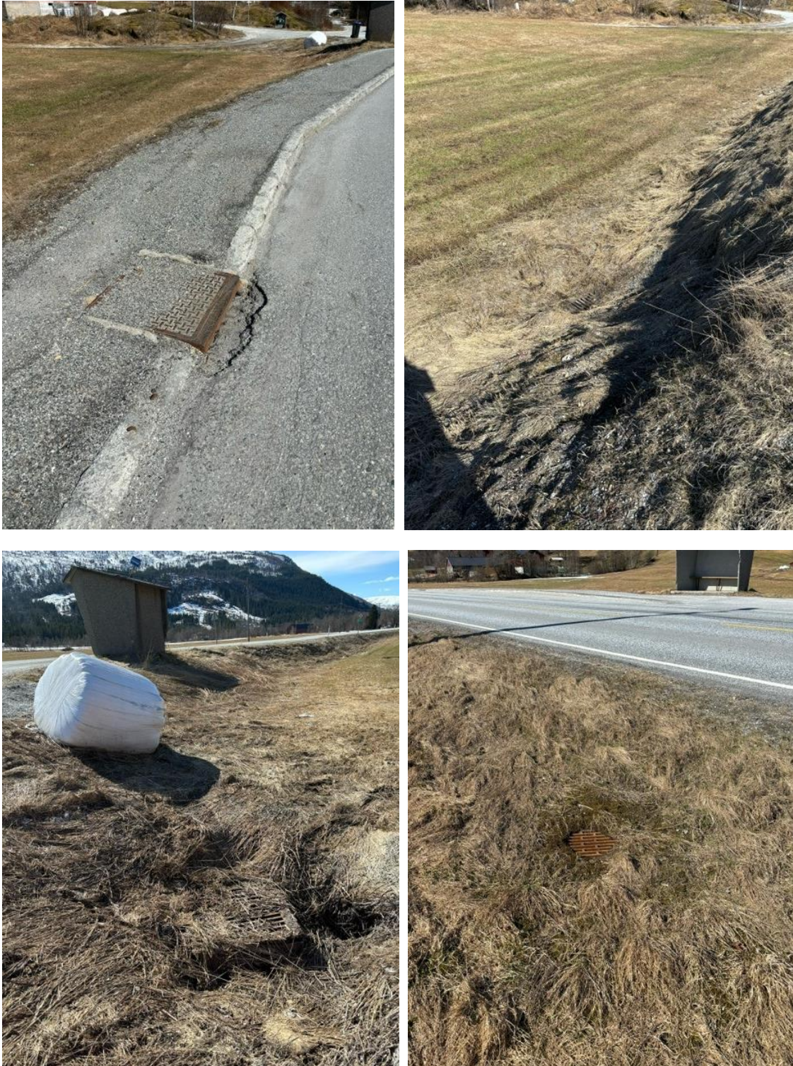
Figur 2.8 Diverse sluk og kummer observert i området ved krysning Lundahovden/Brandsetvegen, ca profil 950-850 (SVV)
