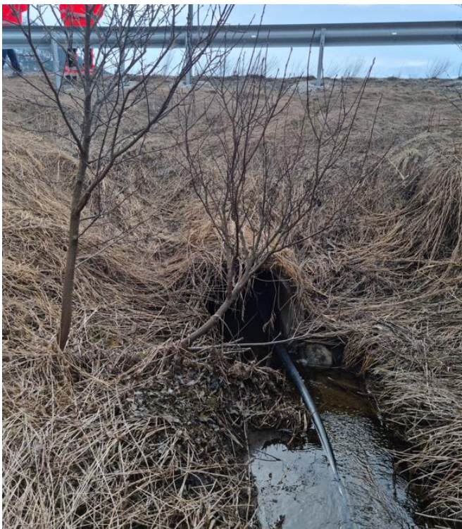
Figur 2.7 Bilde av Ø1000 mm stikkrenne i vest, ca. profil 1035 (SVV)
