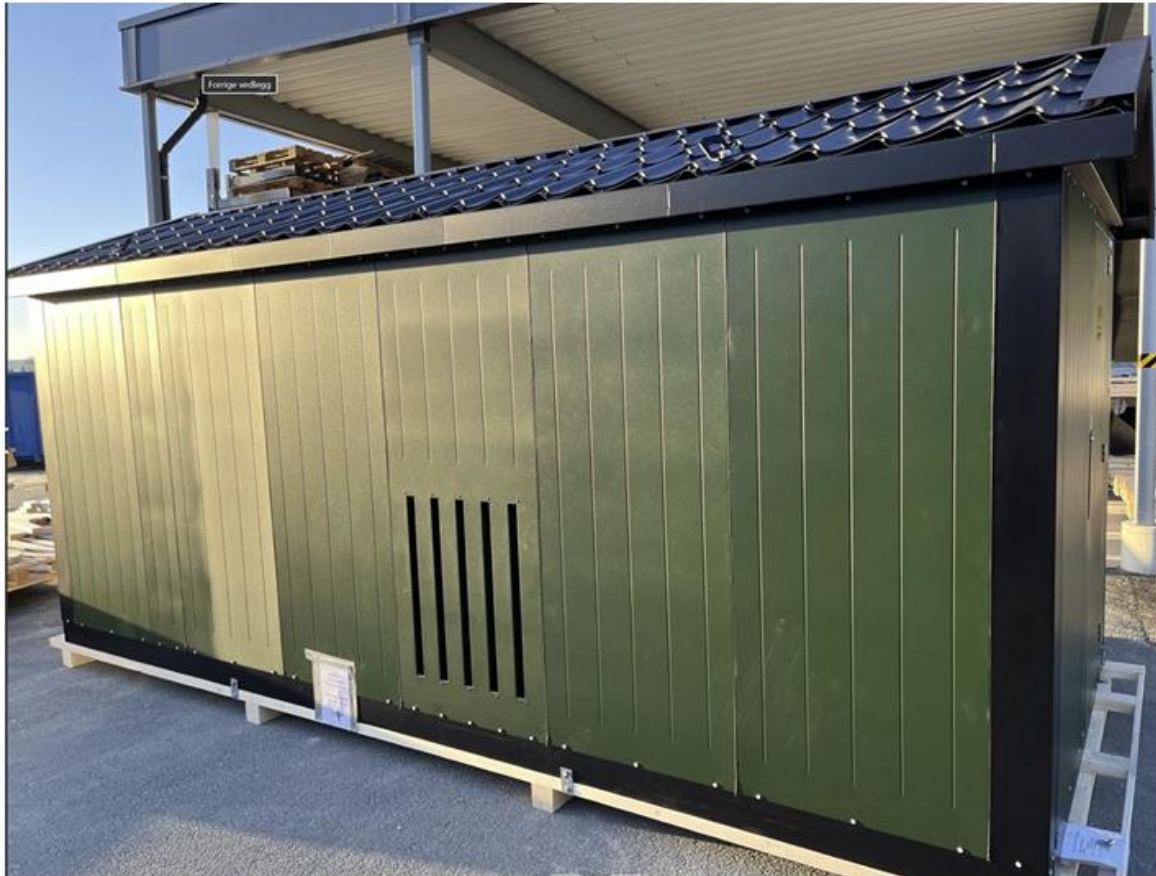
Figur 4: Illustrasjonsfoto av nettstasjon. Bygget vil inneholde høyspent rom, transformator og utstyr for betjening av ventil samt overvåking av slipp av minstevannføringen.
