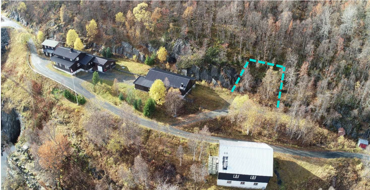
Figur 3-2 Stiplet linje indikerer området der det skal etableres forskjæring for påhugg til adkomsttunnel. Bildet er tatt fra drone, 13. okt. 2022.
