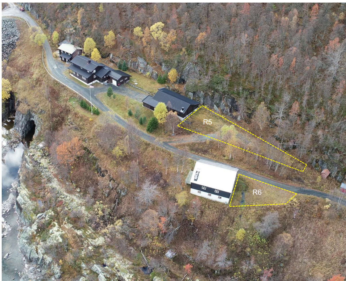
Figur 3-20 Oversikt over riggområdene R5 og R6. Bildet er tatt fra drone, 13. okt. 2022.
