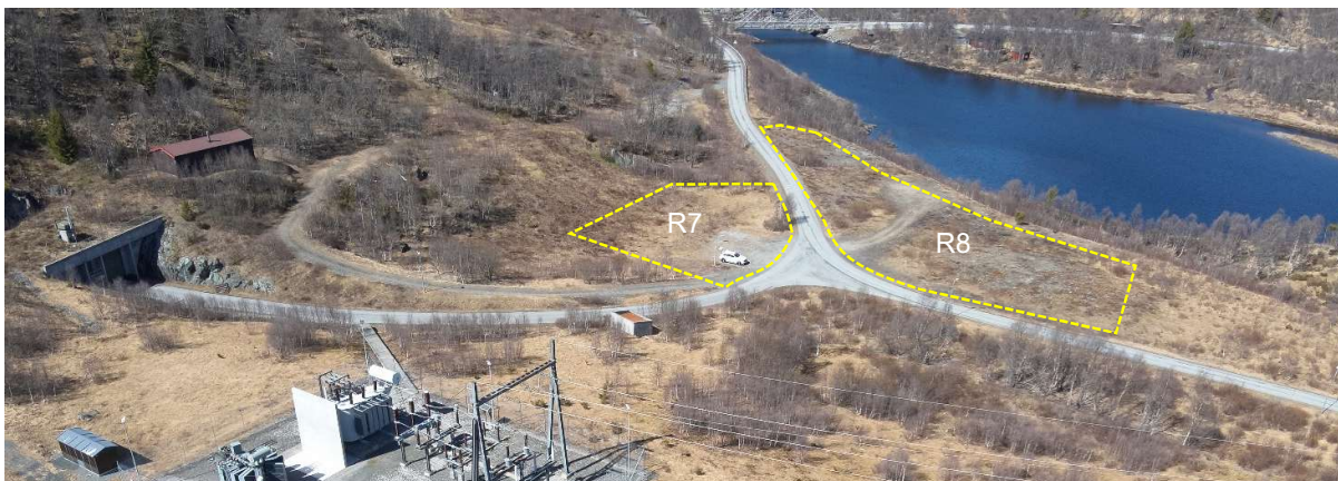
Figur 3-22 Oversikt over området ved Frøystul kraftverk med riggområdene R7 og R8. Kraftstasjonen er plassert 150 m inne i fjellet, og der kjøreadkomst til kraftstasjonen ses helt til venstre. Se avgrensinger av området i arealbruksplan B-103. Bildet er tatt fra drone av Hydro, 30. april 2025.
