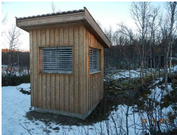
Figur 3-7. Over topp sjakter etableres lufteanordning med lufferister, og her er vist et alternativ med et overbygg med lufferister. Bygget utføres med tilsvarende trekledning og farge som eksisterende nærliggende bygningsmasse som ses på figur 3-5. Dette alternativet anses mer aktuelt enn luftetårn som er vist i figur 3-6. Foto: Hydro.
