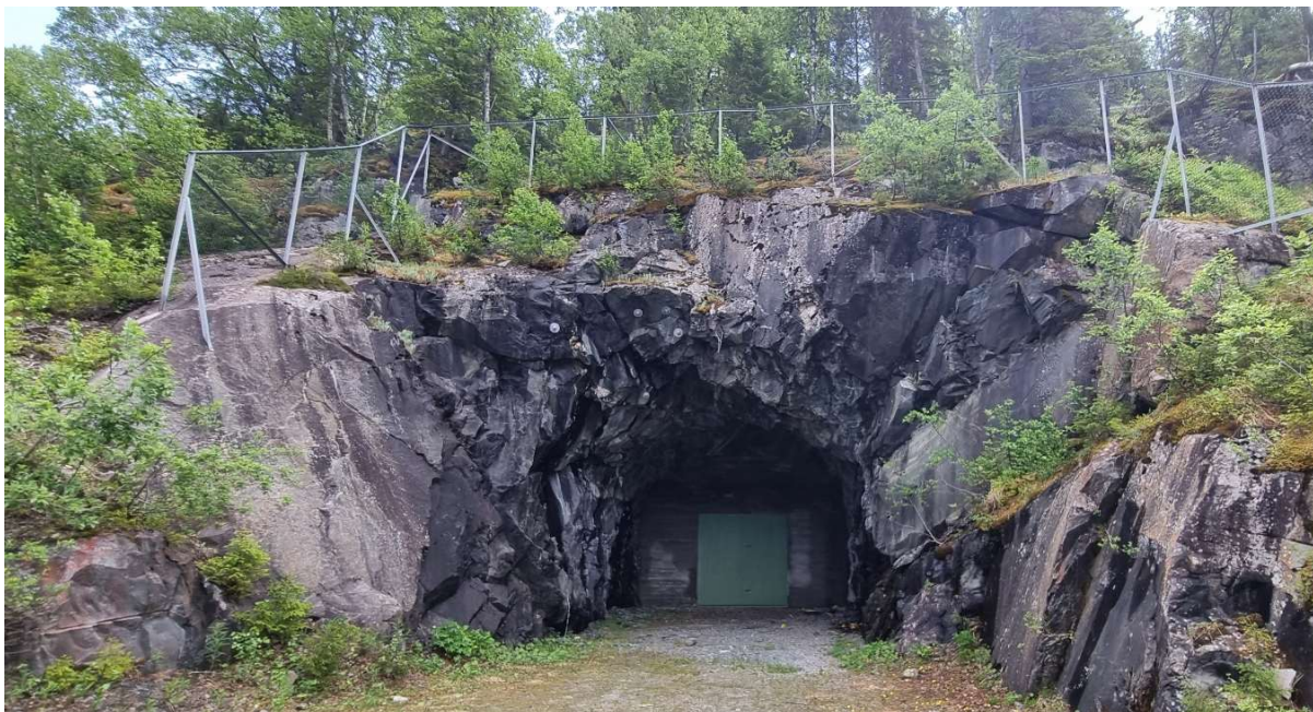
Figur 3-4 Eksempel på hvordan forskjæring i berg frem til tunnel kan utføres. Bildet viser tverrslag 10 til tilløpstunnelen til Vemork kraftverk som eies av Hydro. Berget er rensket for løse blokker, samt sikret med bergbolter. Over forskjæringen er berget rensket for vegetasjon, og sikret med flettverksgjerde. Inni tunnelen ses en betongvegg med stålport. Bildet er tatt 22.06.2023.
