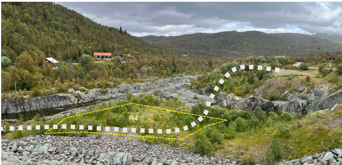
Figur 3-19. Riggområde 3 (R3) til høyre i bildet. Midlertidig anleggsvei (hvit stiptet linje) vil krysse over flomløpskanalen. I forgrunnen vises riggområde 4 (R4).
