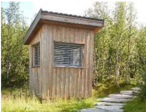
Figur 3-7. Over topp sjakter etableres lufteanordning med lufferister, og her er vist et alternativ med et overbygg med lufferister. Bygget utføres med tilsvarende trekledning og farge som eksisterende nærliggende bygningsmasse som ses på figur 3-5. Dette alternativet anses mer aktuelt enn luftetårn som er vist i figur 3-6. Foto: Hydro.
