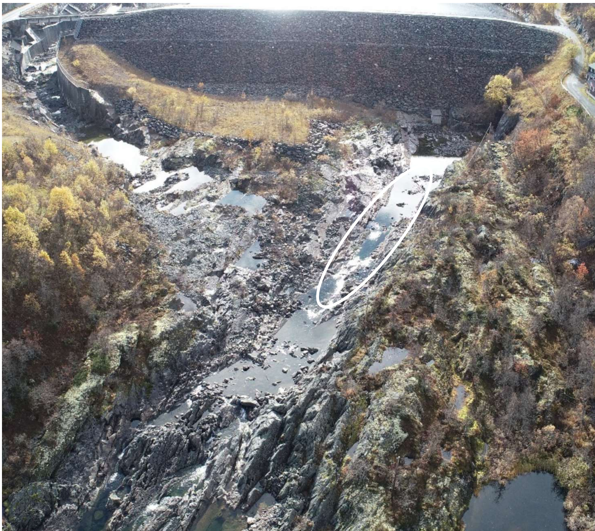
Figur 3-8 Betongterskel for kontrollmåling av minstevannføring etableres på egnet sted trolig innenfor området som er markert med oval hvit sirkel. Bildet er tatt fra drone, 13. okt. 2022.
