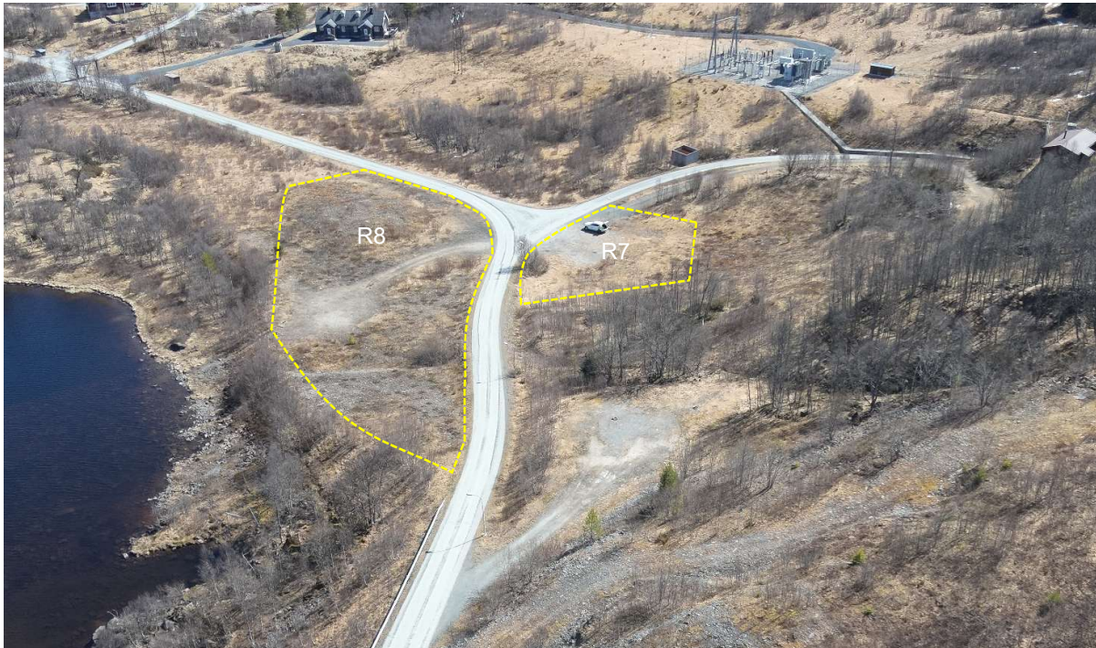
Figur 3-21 Oversikt over området ved Frøystul kraftverk med riggområdene R7 og R8. Se avgrensinger av området i arealbruksplan B-103. Bildet er tatt fra drone av Hydro, 30. april 2025.
