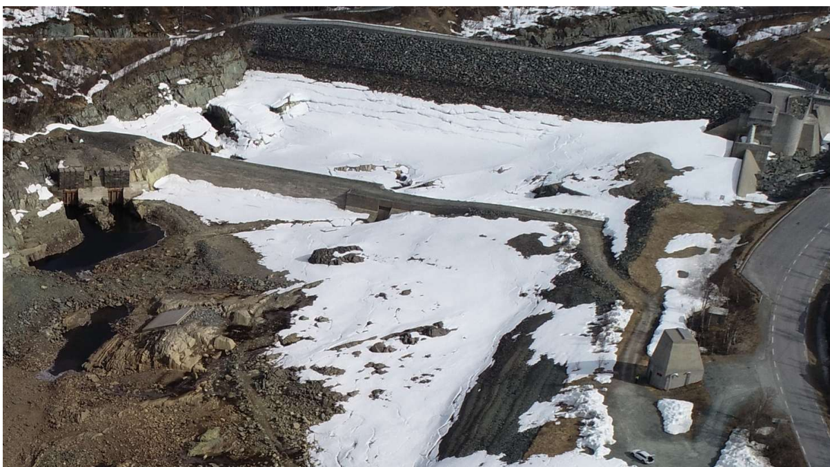
Figur 3-11 Oversikt over området ved lav vannstand kote 900,55. Kranbil kan kjøre på toppen av gjenstående dam og bort til revisjonslukene som ses til venstre. Bildet er tatt fra drone av Hydro, 14. mai 2020.
