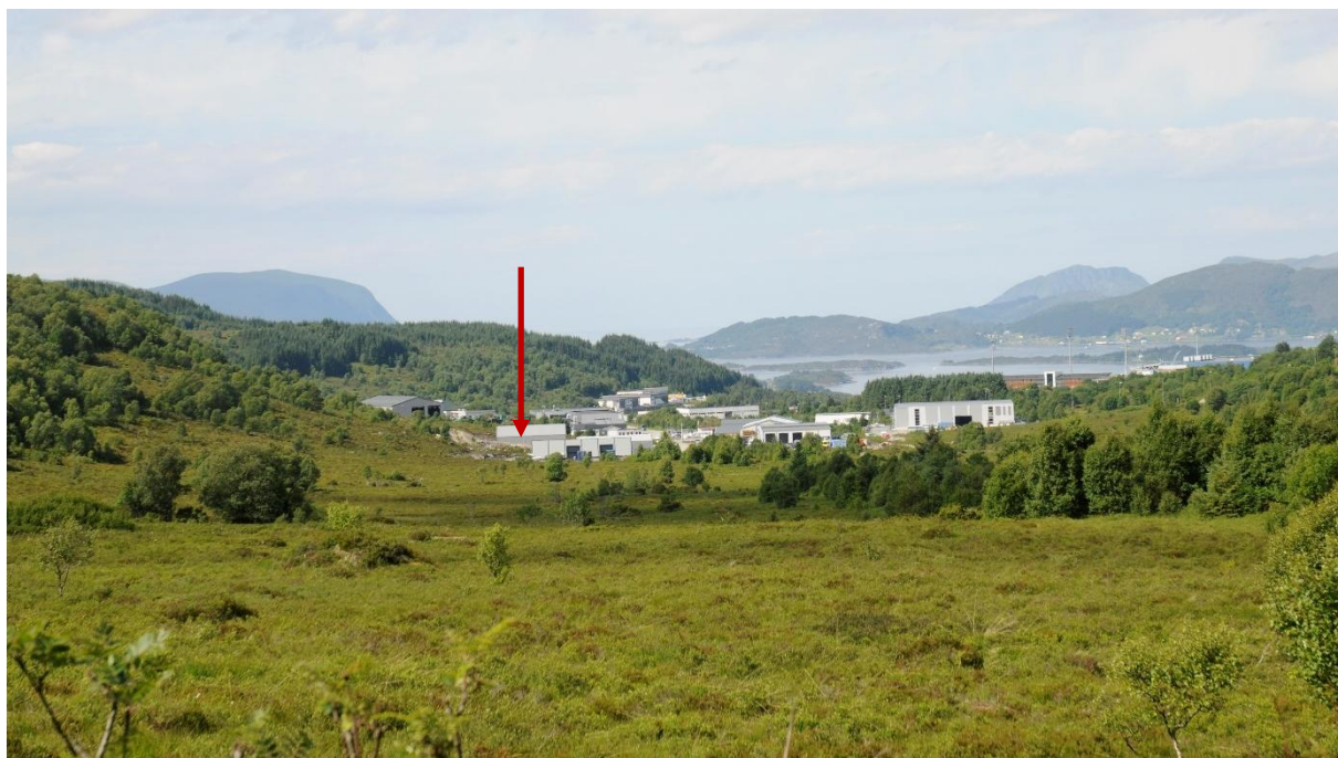
Figur 5-28. Bilde tatt fra Hareidseidet, mot Ulsteinvik. Rød pil markerer omtrentlig plassering av ny transformatorstasjon. Bygget vil i stor grad skjules av eksisterende bebyggelse, og ikke være framtrædende i landskapsbildet.
