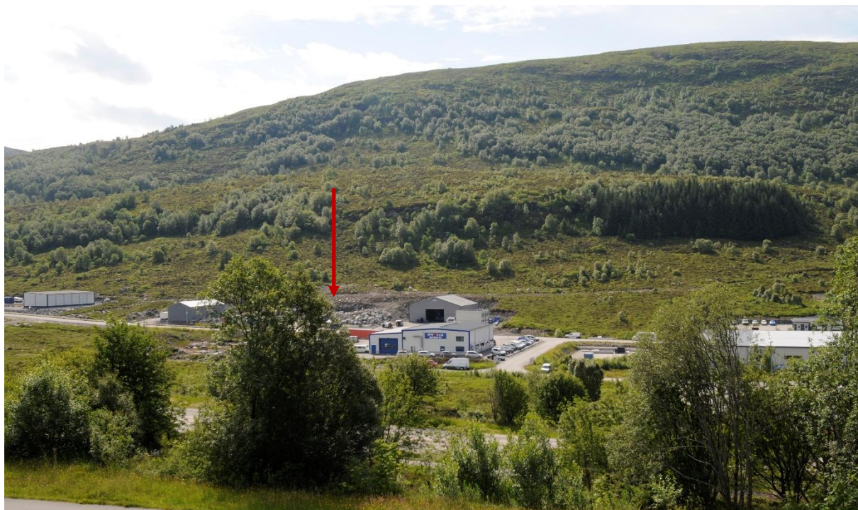
Figur 5-27. Bilde tatt fra Sunnmøre folkehøgskule. Rød pil markerer omtrentlig plassering av ny transformatorstasjon.
