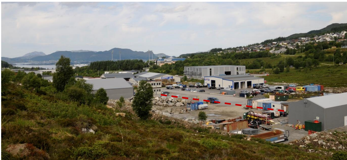
Figur 5-34. Jordkabel legges langs internveien i industriområdet. Rød stiplet linje viser omtrentlig plassering.
