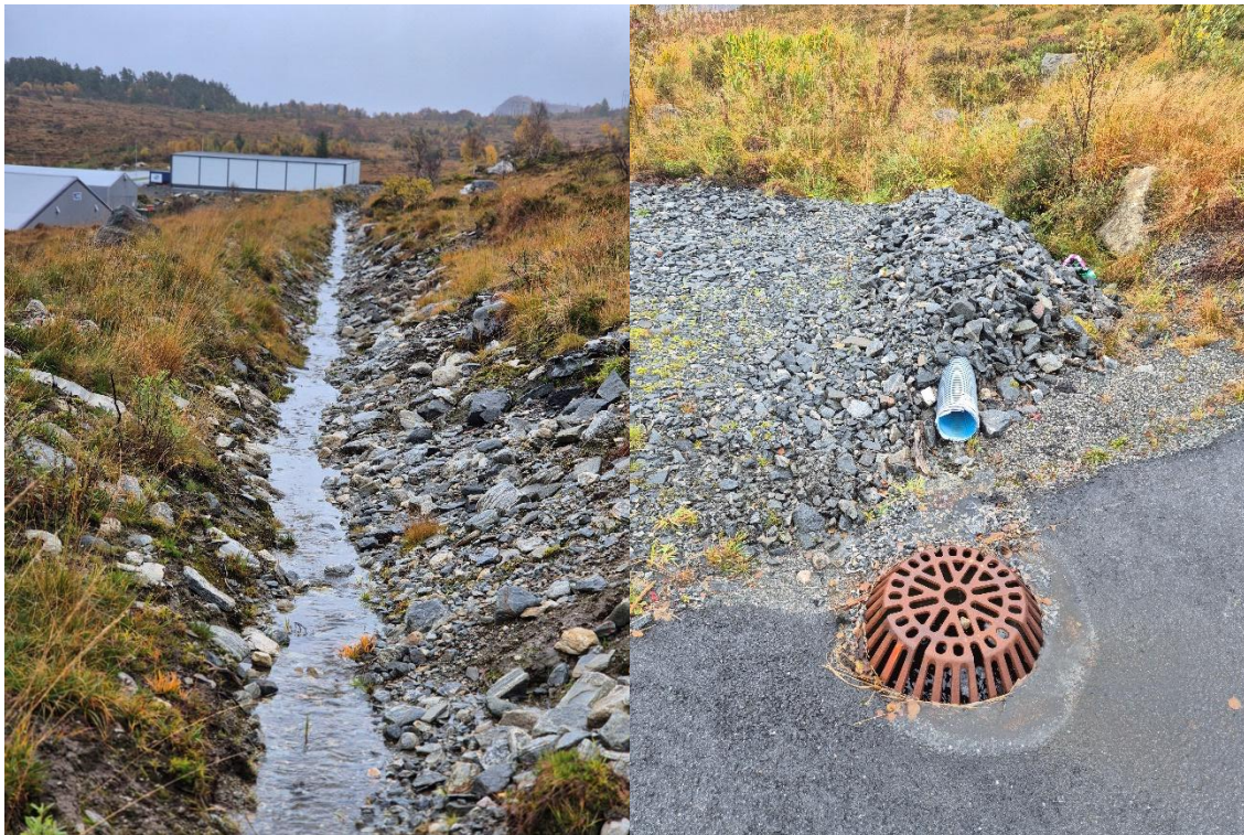
Figur 6-3. Venstre: Avskjæringsgrøft sør for stasjonstomt. Bilde tatt mot øst. Ny stasjonstomt vil ligge mot venstre for bildet (utenfor bilde). Høyre: Kum til eksisterende drenering på næringsområdet, i nord-vestre hjørne av ny tomt. Foto Norconsult.
