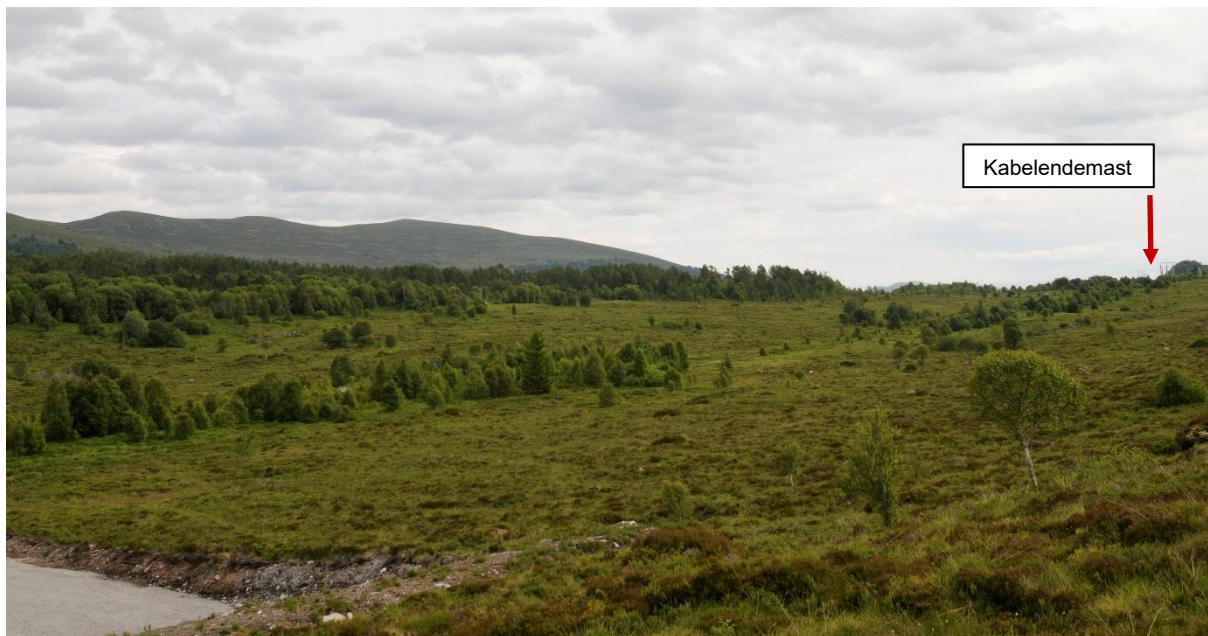
Figur 5-32. Bilde tatt fra Saunås industriområde. Kabelendemastens plassering er markert med rød pil. Eksisterende master er svært lite synlig, noe som vil være tilfelle for ny kabelendemast også.
