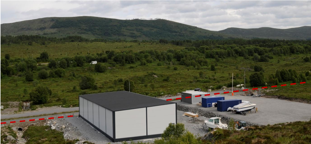
Figur 5-35. Jordkabel fortsetter videre østover, og ut av industriområdet. Rød stiplet linje viser omtrentlig plassering.
