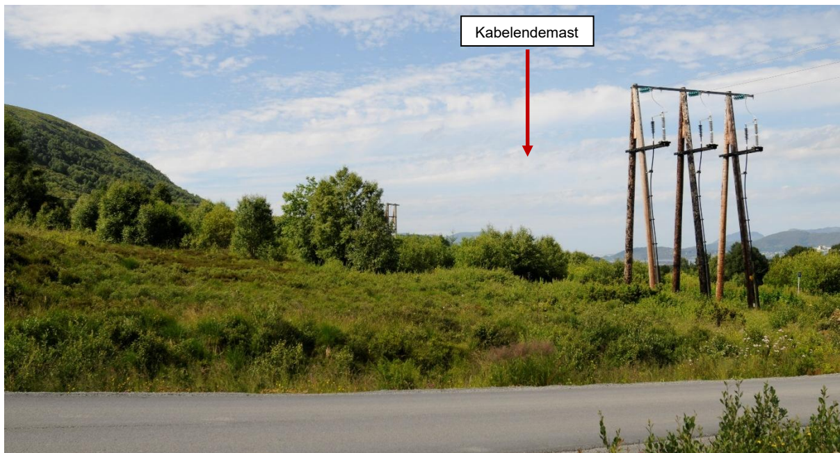
Figur 5-31. Ny kabelendemast vil etableres mellom de to mastene som vises på bildet. Rød pil viser omtrentlig plassering.
