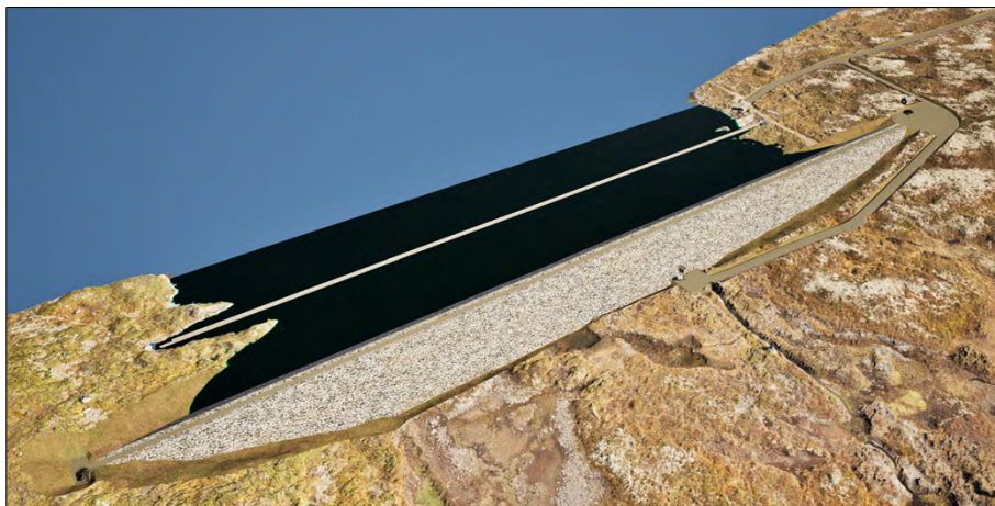
NY DAM ORSENDVATN. Illustrasjonen viser nye dam Orsendvatn. Dammen bygges med nedsenket kjørebane. Illustrasjonen er hentet fra forelagt DML.
