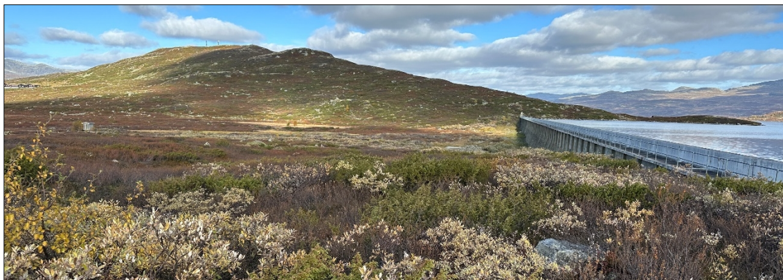
DAM ORSENDVATN. Terrenget i nedkant av dam Orsendvatn er lett tilgjengelig. Tydelig arealavgrensning er derfor særlig viktig i anleggsperioden. Bildet er tatt under NVEs befaring i 2023.
