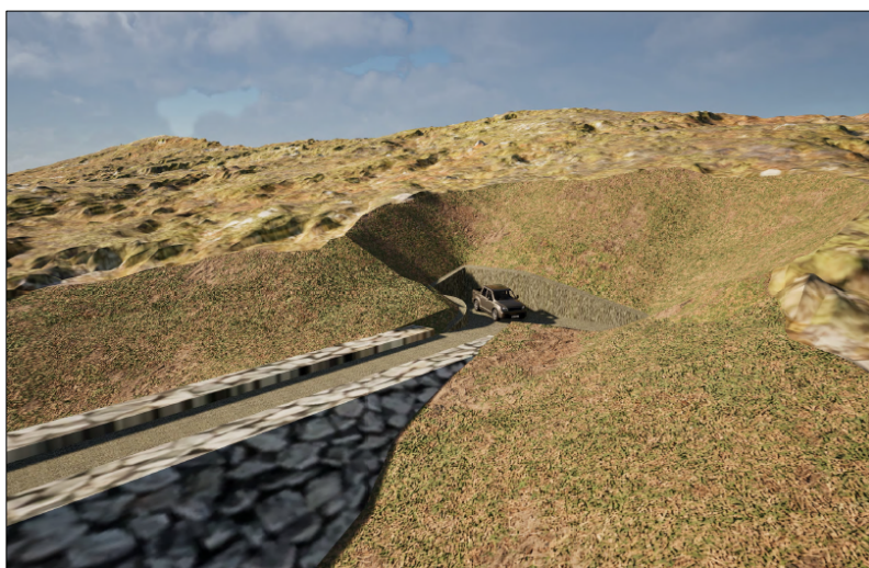
SKJÆRINGER. Bygging av ny dam Orsendvatn gir store og markante skjæringer i nordenden. NVE mener konsesjonær må sikre at skjæringene etableres og istandsettes på best mulig måte. Illustrasjonen er hentet fra forelagt DML.
