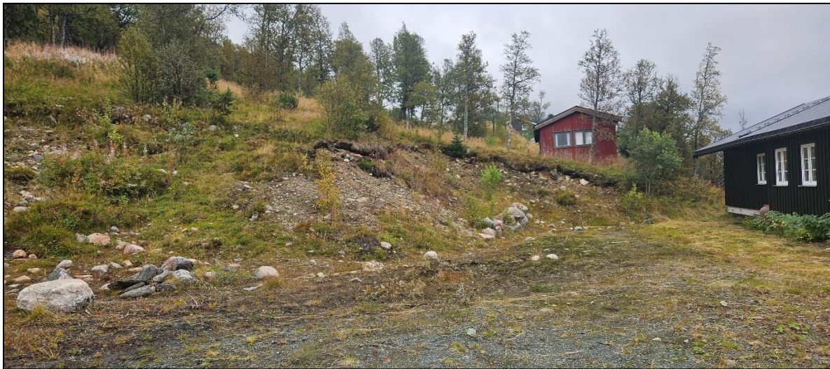
Figur 6: Nord i kartleggingsområdet observeres det usortert løsmasser i mindre skråning nord for bolighus. Større partikler som stein og blokk er avrundet. I skråning har det gått mindre utglidninger.
