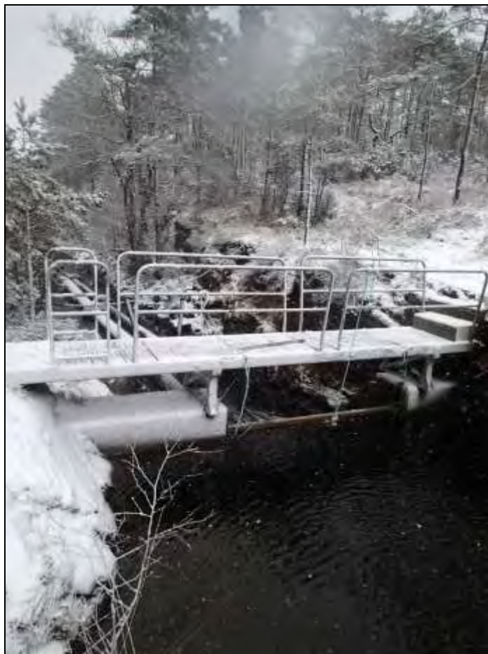
Figur 3. Demningen i utløpet av Håvikvatnet, fotografert fra oppsiden ved overløp 24. februar 2016.
