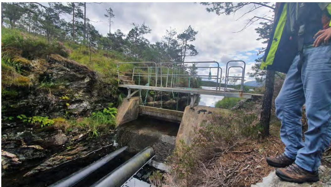
Figur 1-5: Foto av demning. Bilde tatt mot sørøst (Håvikvatnet). Vannrør i bunn av demning er eksisterende uttak av vann fra Håvikvatnet til stamfiskeanlegg. Foto: COWI
