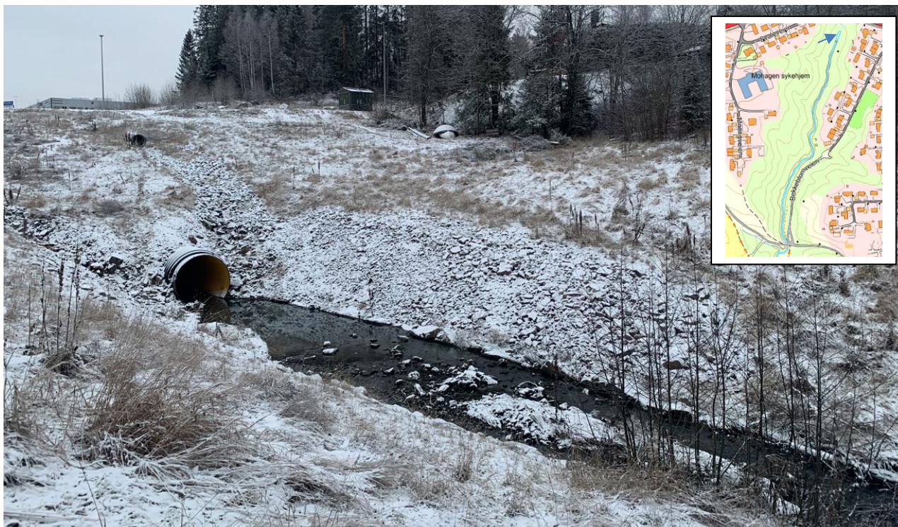
Figur 5 - Ved kulvertutløp nord for tiltaket, tatt på befarings 30.11.2021
