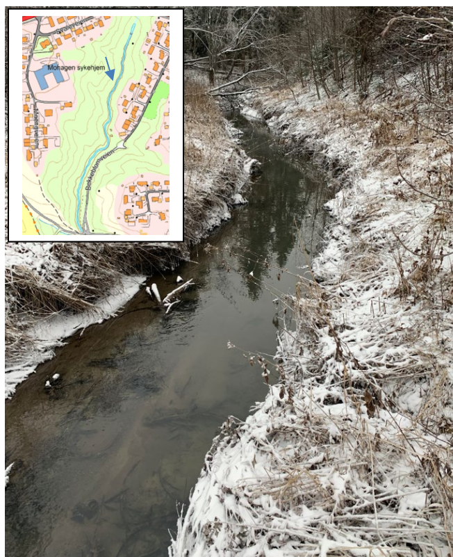
Figur 7 - «Litt» erosjon fra befarings 30.11.21
