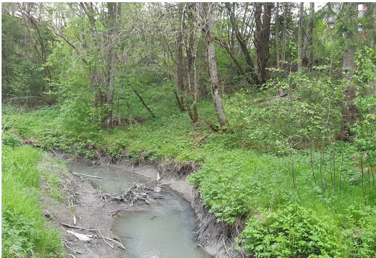
Figur 4 «Litt» erosjon - Foto fra befaring 27.05.2020
