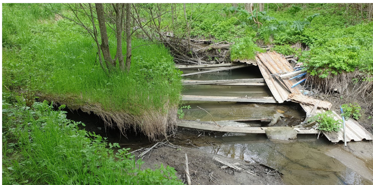
Figur 2 Observert søppel - Foto fra befaring 27.05.2020.
