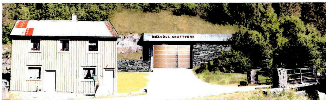
Bilde som viser det gamle bolighuset med tunnelåpningen rett til høyre
