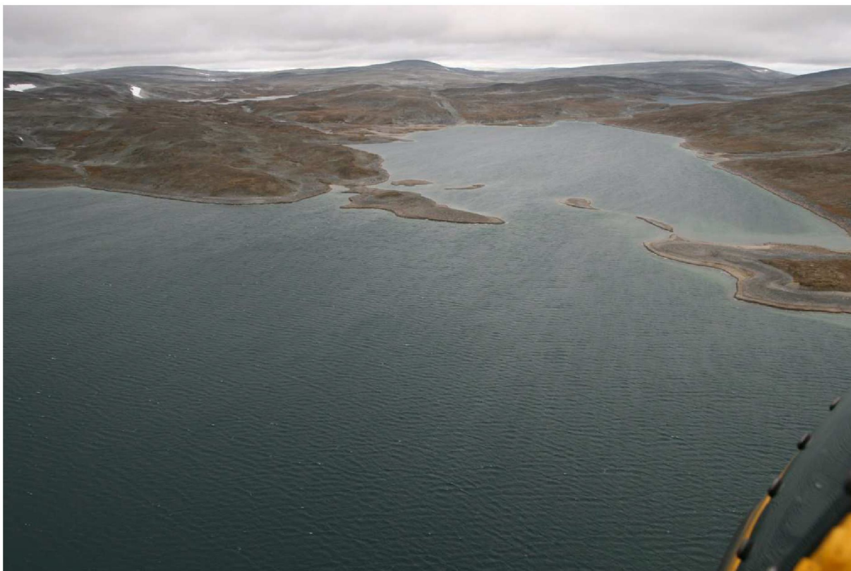
Bilde 4-6: Stuora Mollešjávri sett oppstrøms fra utløpet. Inntaket er innerst til høyre i bildet (knapt synlig)
