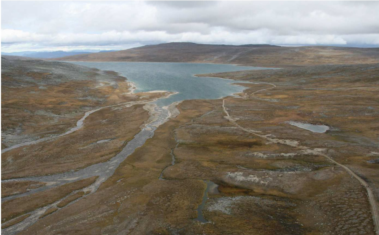
Bilde 8-1: Njulggojohka (og overført vatn fra Stuora Mollešjávri og Sarvvesjávri) sitt utløp i Ábojávri. Det pågår erosjon i løsmassene i reguleringssonen når magasinet er nedtappet.
