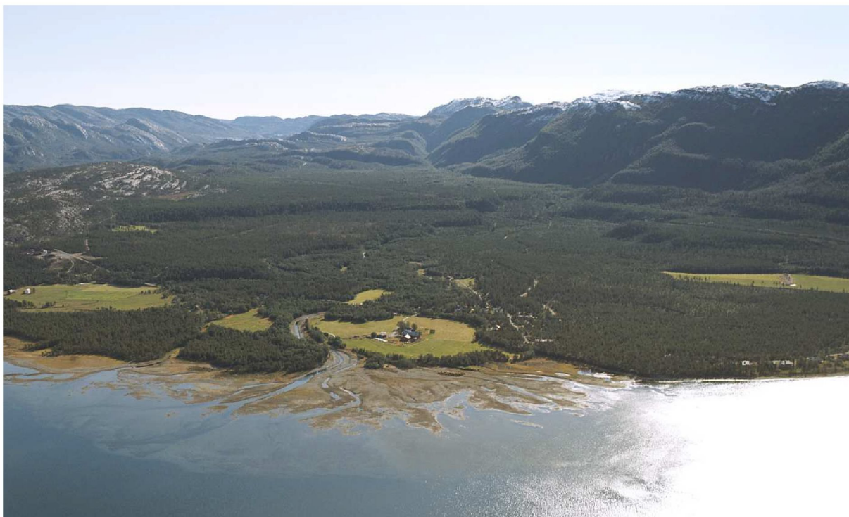
Bilde 4-14: Utløpet av Njemenjáikojohka i havet (Kvænangsbotten). Forbygningene (kanaliseringene) i utløpet kan skimtes.
