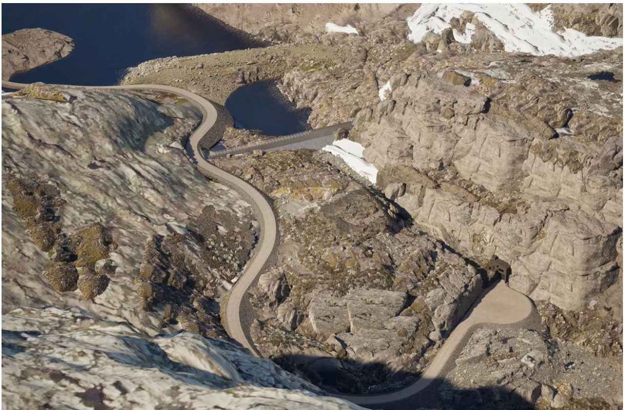
Figur 5. Eksempel på fremtidig situasjon (modellert) fra vest mot øst ved portalområdet. Gilavassdammen og villreinovergang i bakgrunnen. Endelig utforming av adkomstvei vil avhenge av detaljert veiføring. Endelig utforming av villreinovergang vil avhenge av tilgjengelige masser.
