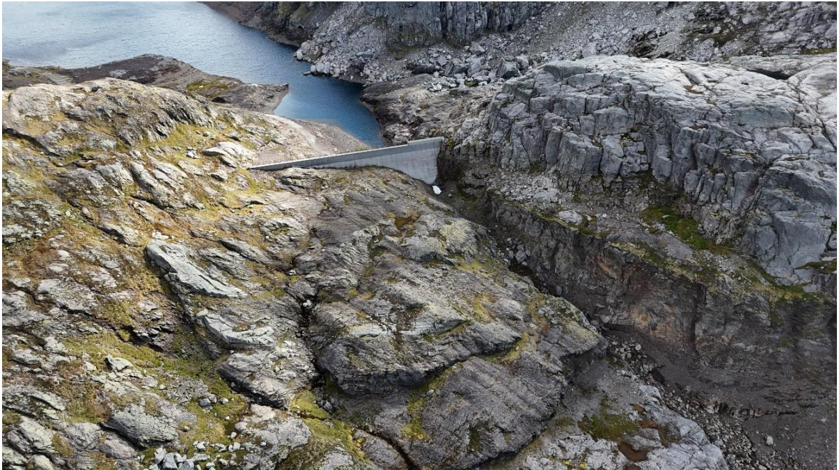
Figur 4. Dagens situasjon (dronefoto) fra vest mot øst ved portalområdet. Gilavassdammen i bakgrunnen.
