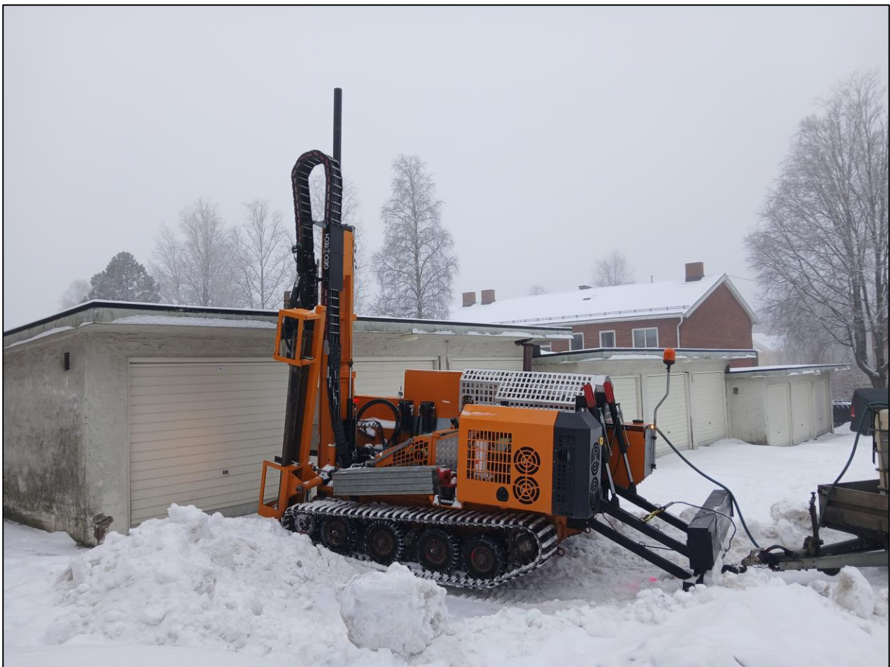
Bilde fra boring.
