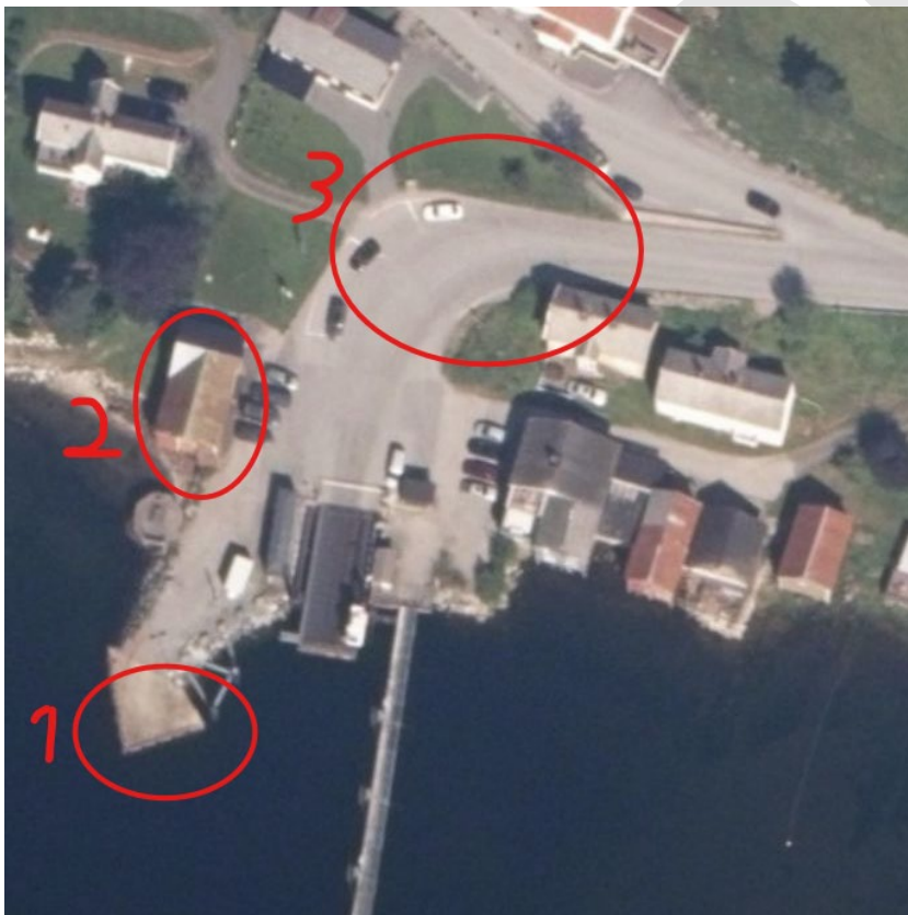
Figur 11 Bildet viser utfordringer tilknyttet kaianlegg ved Kvanne ferjekai. 1. Usikre dybder og grunnforhold, 2. Smalt ved verneverdig bygning, 3. Bratt bakke og 90 grader sving.
