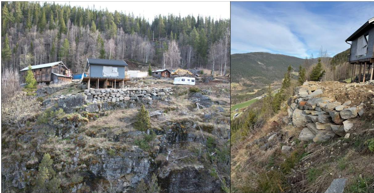
Figur 13: Støttemur som er etablert ut mot bergskrenten sør i kartleggingsområdet. Bilde til venstre er tatt mot nord, mens bildet til høyre er tatt mot vest.
