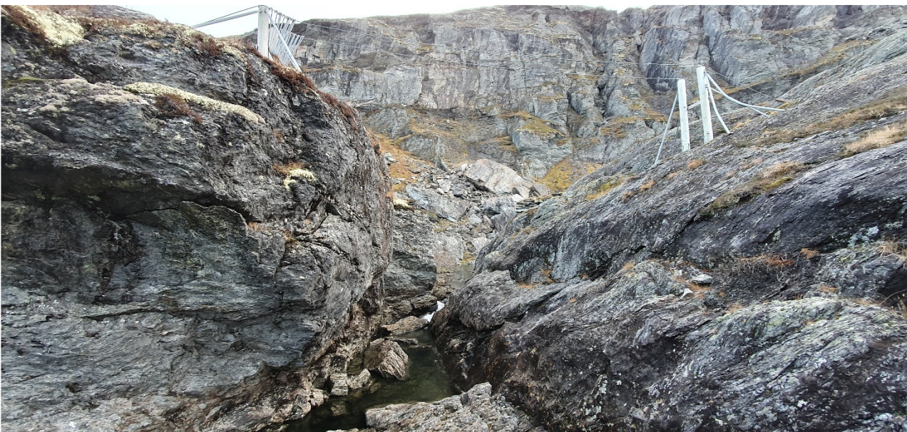
Figur 5 Gjel under gangbru, vertikal skråning venstre side på bildet, bratt og deretter avslakende skråning på høyre side. Merk utoverhengende fjell på venstre side i forkant. Mulig fortsettelse av svakhetssona ses i fjellet i bakgrunnen
