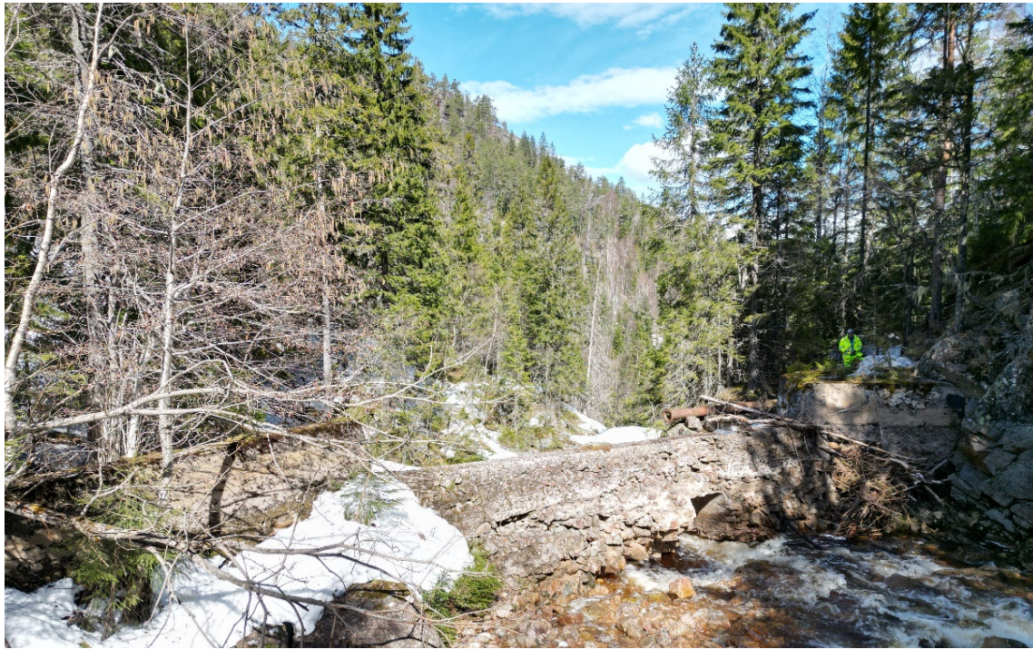
Bilde 5: Område for inntak, sett frå sør. Eksisterande damterskel med overløp midt på bildet. Ny dam blir som påstøyp til eksisterande.
