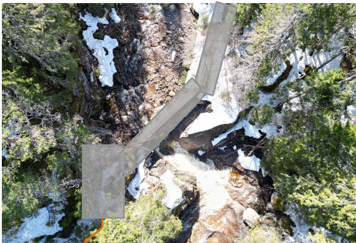
Bilde 1: Inntaksområde sett ovanfrå, inntakskasse markert til venstre og dam i midten og til høyre. Vassveg markert med orange. Restar av tidlegare dam visest i bakgrunnen.
