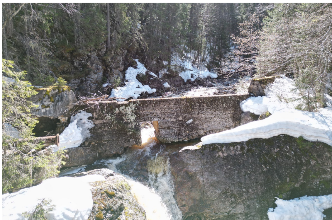
Bilde 2: Område for inntak, sett frå nord. Eksisterande damterskel med overløp midt på bildet. Ny dam blir som påstøyp til eksisterande.
