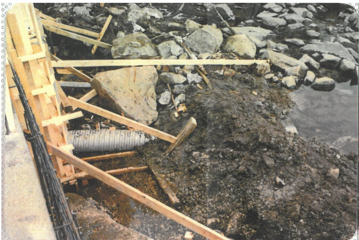
Figur 12 Biletet viser at fangdammen held vasstanden noko høgare rett oppstrøms for dammen enn det den vil vere når dammen er heilt fjerna.
