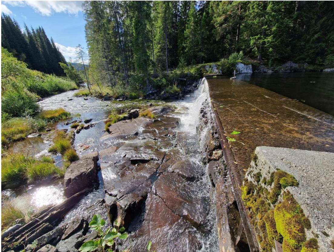
Figur 5 Overløpet på dammen og elva vidare ned mot Lårdal
