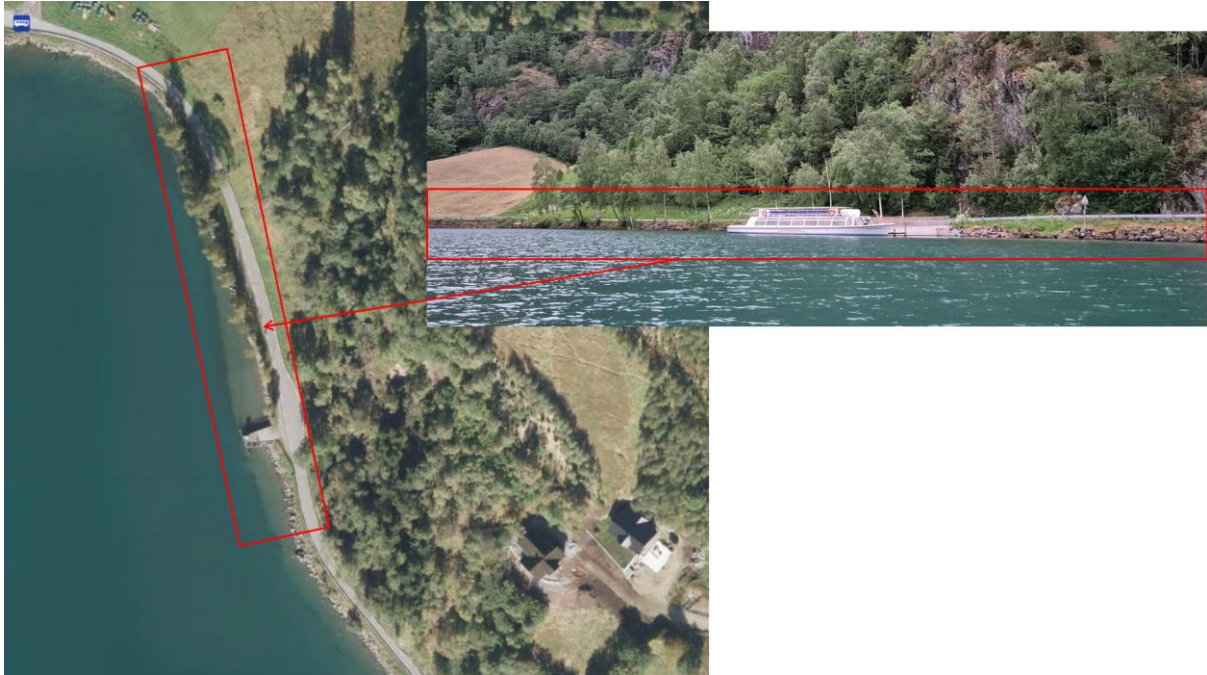
Figur 9: Vannkanten mellom Sandeåsen busstopp og videre sørøstover. Det er store steiner i vannet langs hele vannlinjen. Bilde med flyfoto hentet på kart.finn.no (4) og bilde fra mail sendt av kunde.
