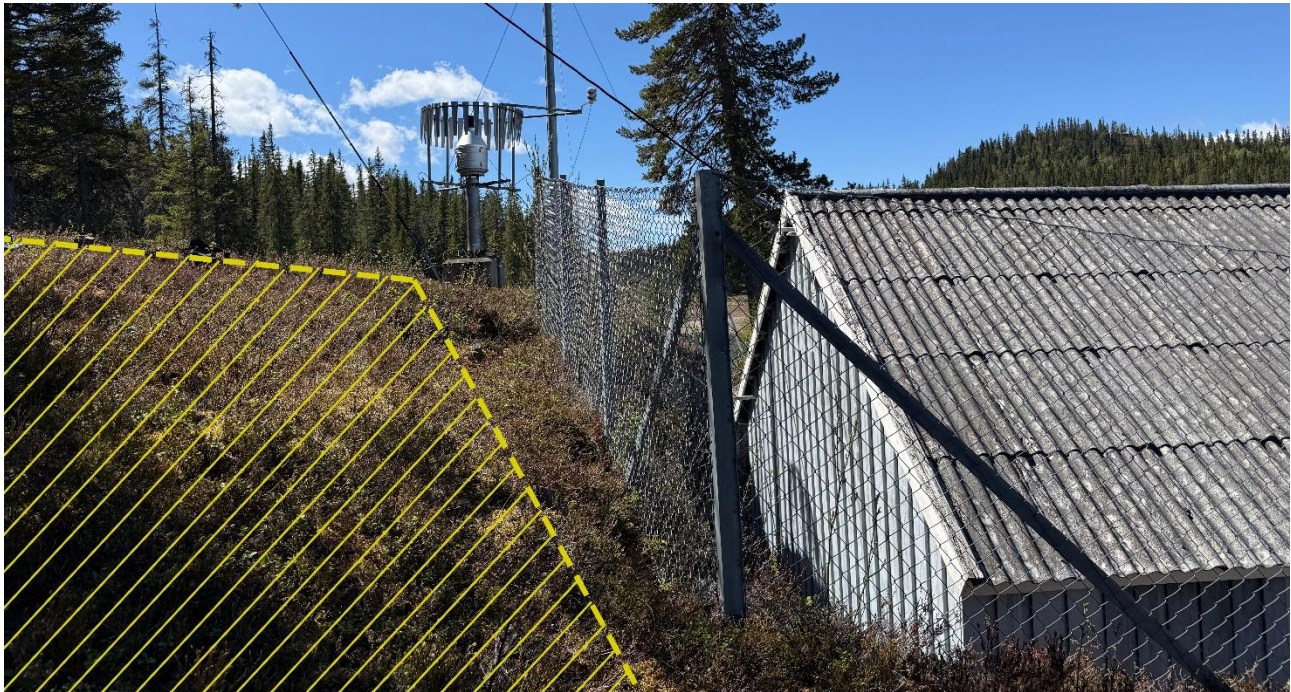
Figur 3-13. Riggområdet etableres bak lukehuset. Området må være stort nok til at mobilkranen kan stå på tvers og utføre arbeider på inntaksluken.
