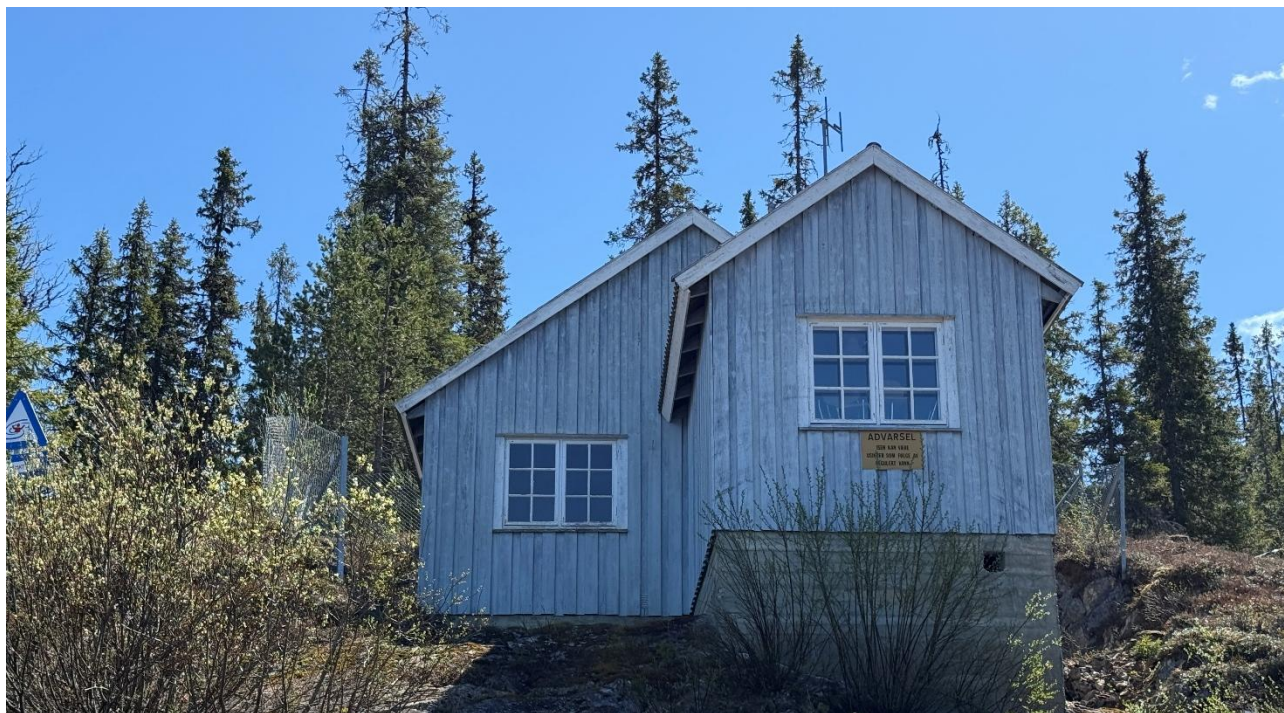
Figur 3-11. Dagens lukehus ved Breivatn.
