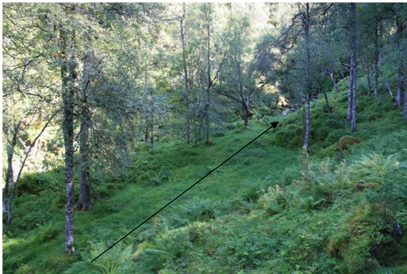
Inntaket og rørtraceen i Gravdalsgjelet (pil)
