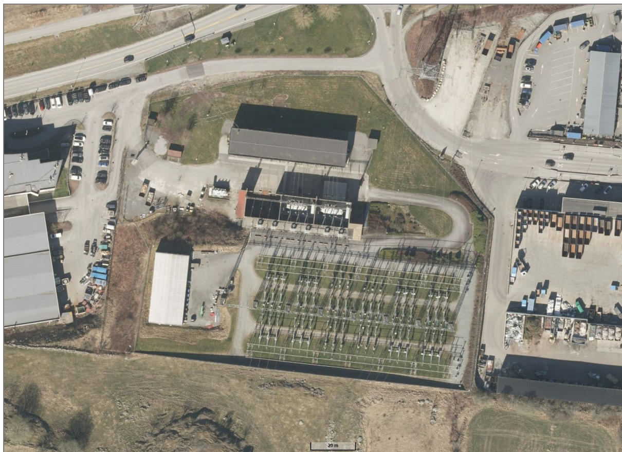
Figur 13 Eksisterende Bærheim transformatorstasjon. Kilde: Norgeskart.
