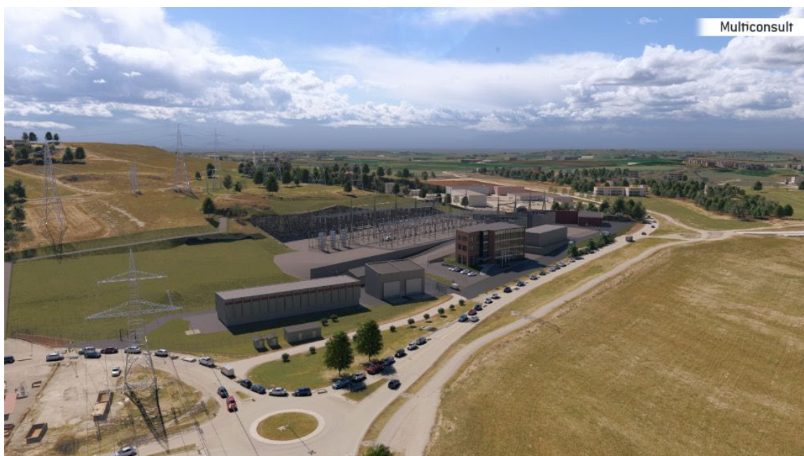
Figur 24 Visualisering av Humleberget og Bærheim transformatorstasjoner sett fra nordøst.
