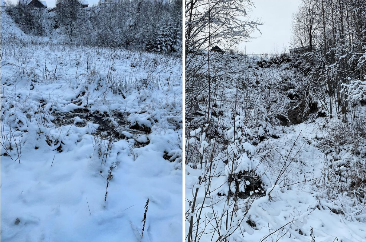
Figur 3. Bildet til venstre viser sletta mot Almemoen 71, på nedsiden av utglidningen i 2016. Bildet til høyre viser rasgropa etter utglidningen i 2016 (kilde: Ringerike kommune)
