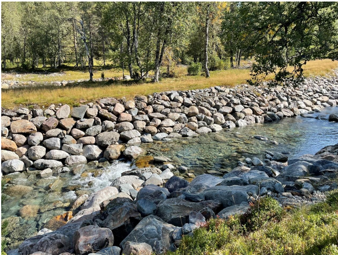
Figur 5: Ved Holmen (venstre side) flott detalj ved terskel og erosjonssikring
