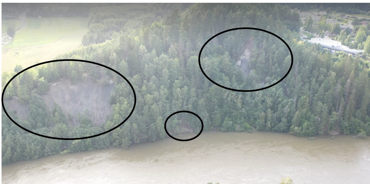
Figur 4: Utklipp fra dronevideo viser utglidninger (markert med svarte sirkler) i skråningen på nedsiden av Hvelven omsorgssenter. Utglidningene virker å være av eldre dato. Omsorgssenteret kan ses til høyre i bildet (Video: Tom-Erik Bakkely Aasheim, Ringerike kommune).
