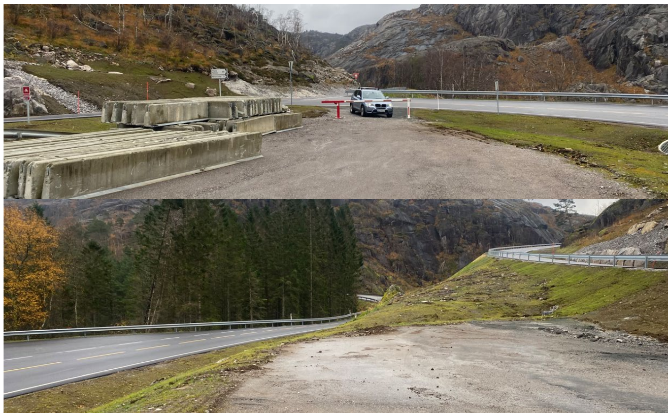
Figur 13 Avkjørsel Fv 44/Tellenesveien. Øvre bilde tatt mot nord-vest. Nedre bilde tatt mot sør-øst
