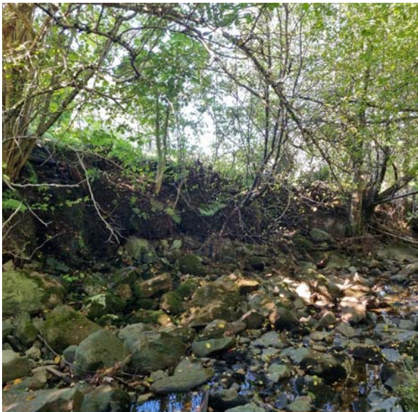
Bilde 12: Viser en erosjonskant med en høyde på opptil ca 3 m.
