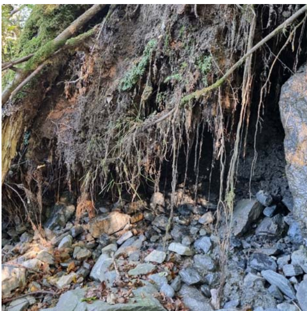
Bilde 13: Erosjonen har medført undergraving under vegetasjonsdekket på den nordøstlige delen av elven.
