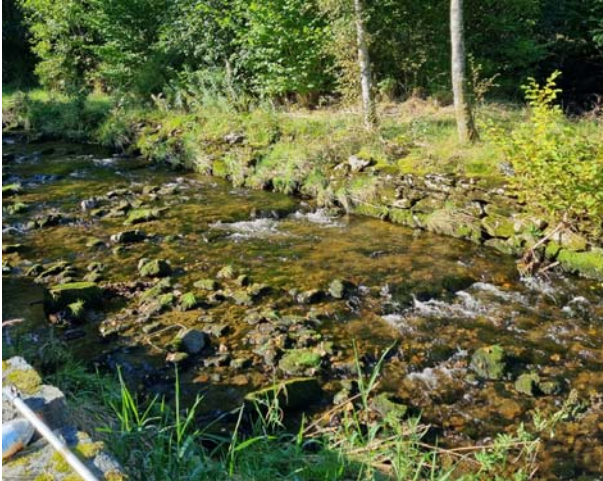
Bilde 3: Langs deler av Oselva er det satt opp plastring/mindre tørrmurer.
