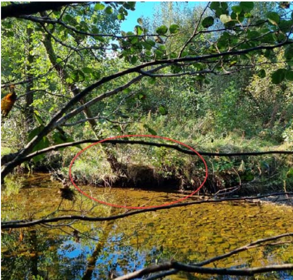
Bilde 6: Viser eksempel på område der det er erodert i torvmasser og tre står på skeive.
