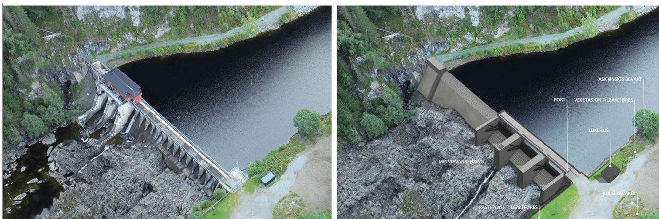
Figur 1: Eksisterende dam til venstre og ny dam til høyre. (Illustrasjon Multiconsult)
