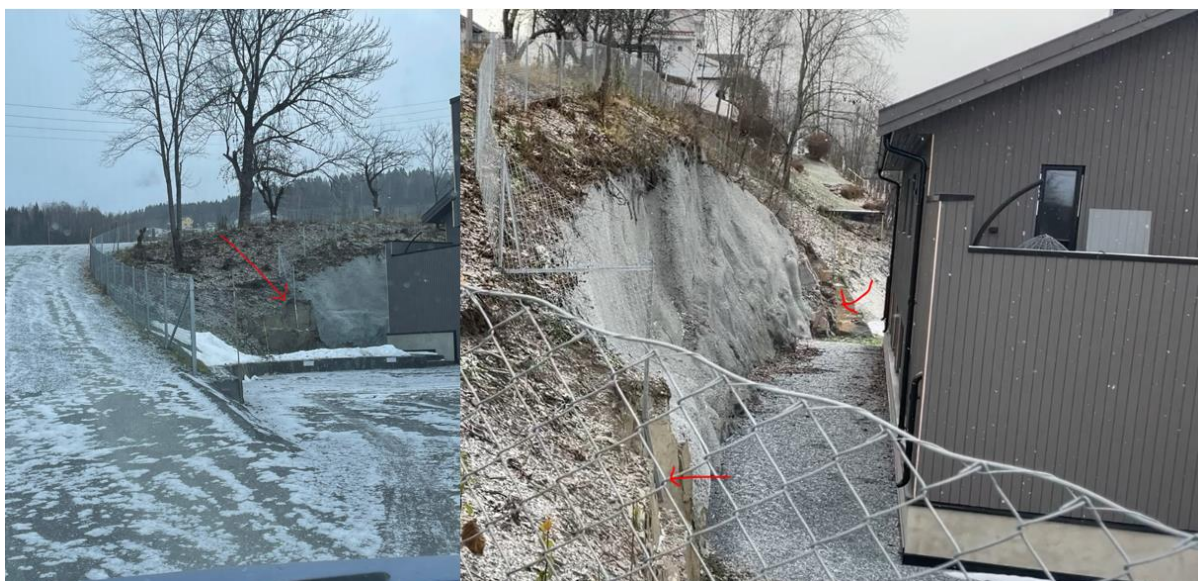
Figur 21: Fjellskjæring ved Arneberg, utenfor prosjektområde (lokasjon 8, Figur 8)
