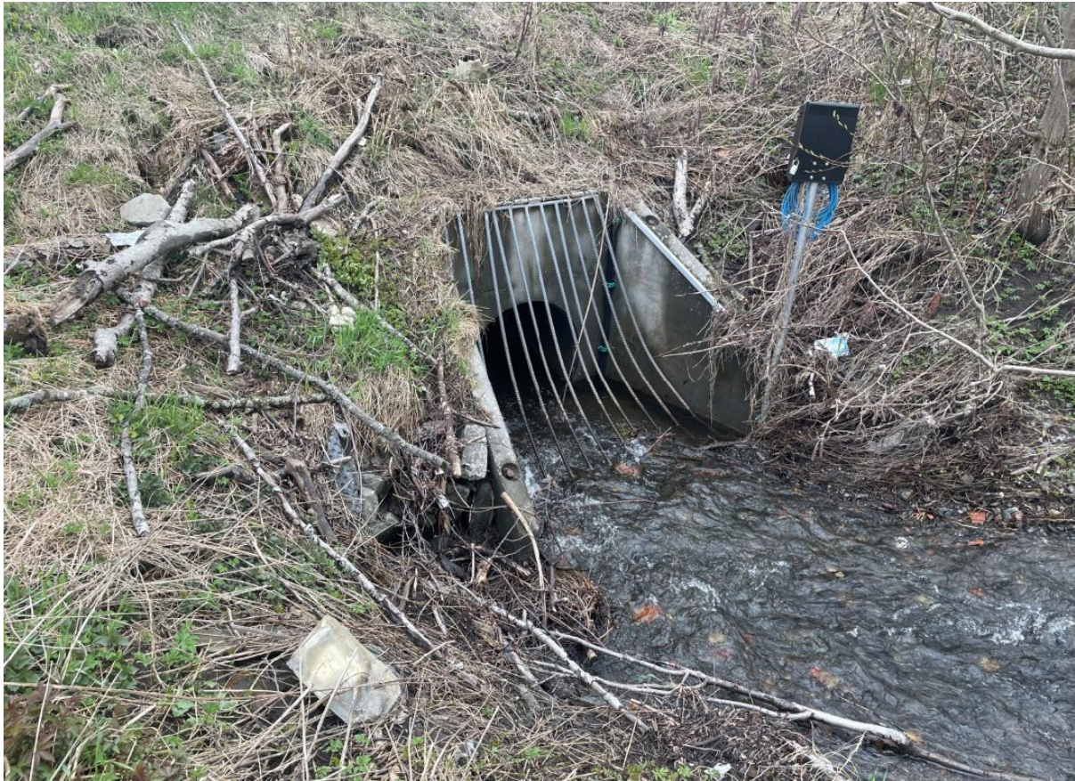
Figur 26: Kulvert under Fabrikkgata, observert fra sørside av veien. (Lokasjon 1 på figur 25)
