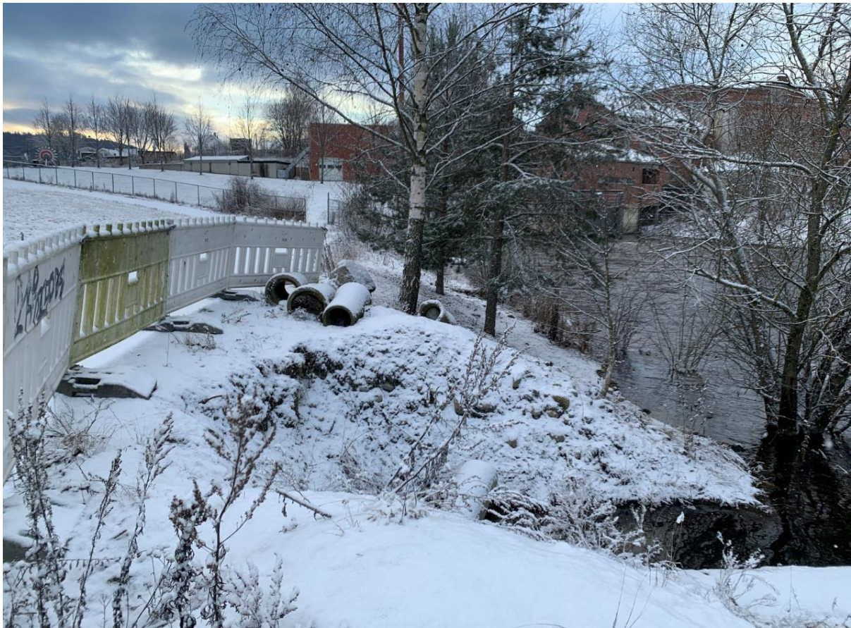
Figur 5: Vestfossen idrettspark, grove masser ned mot Vestfosselva. Lokasjon 3 figur 4.
