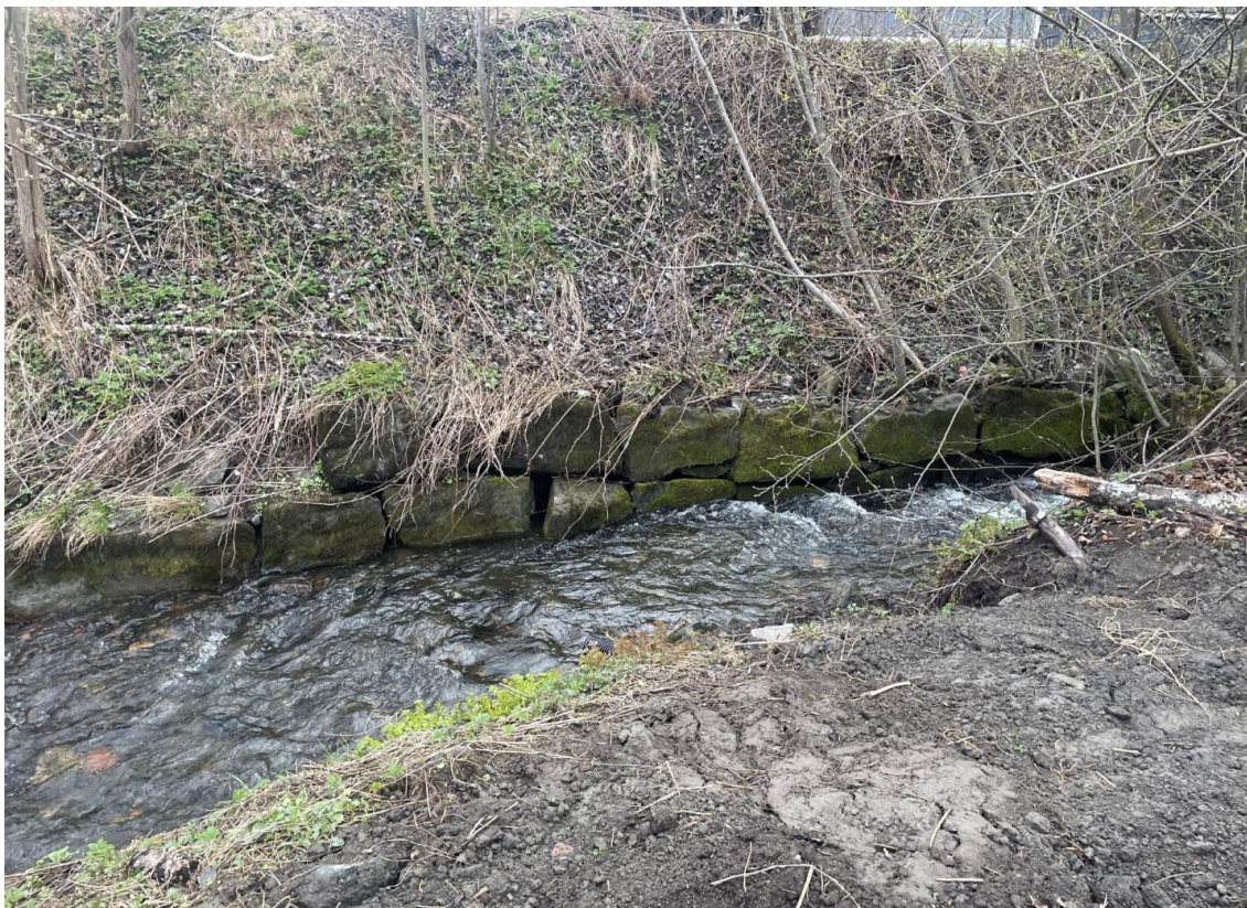
Figur 27: Erosjonssikring langs bekk ved Fabrikkgata, observert fra vestsida av bekken (lokasjon 2 på figur 25)
