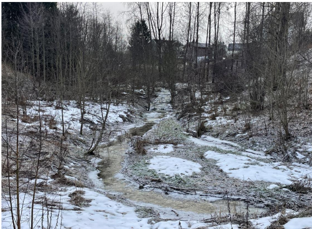
Figur 15: Sikret ravine mellom Sørenga og Vestfossen idrettspark, sett i retning sørøst. Lav terrenggradient. Antatt lokasjon hvor bekk er lagt om under sikringsarbeider i 2007 (flyttet mot nordvest bort fra skråningsfot) (lokasjon 5, Figur 8)
