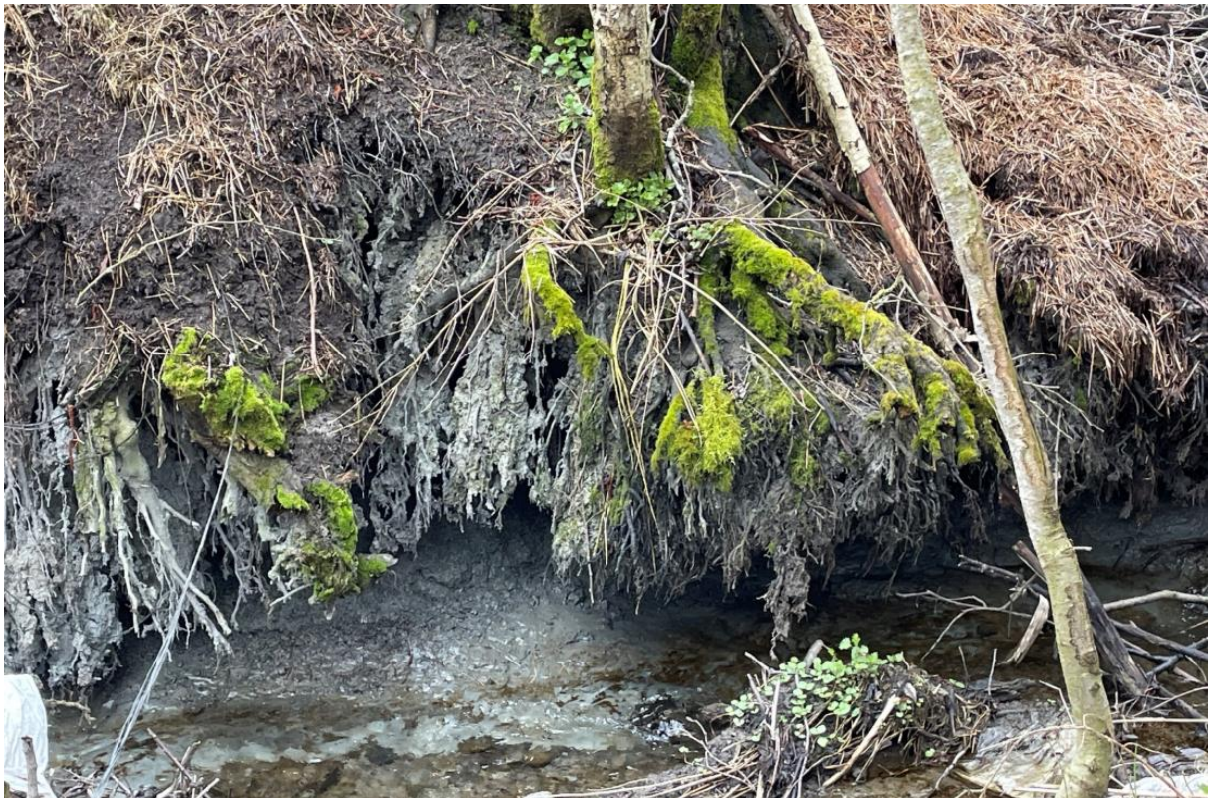
Figur 7: Bilde fra lokasjon 3 markert i figur 1. Noe erosjon, tegn på undergraving i bekkekant. Eksponert silt/leire
