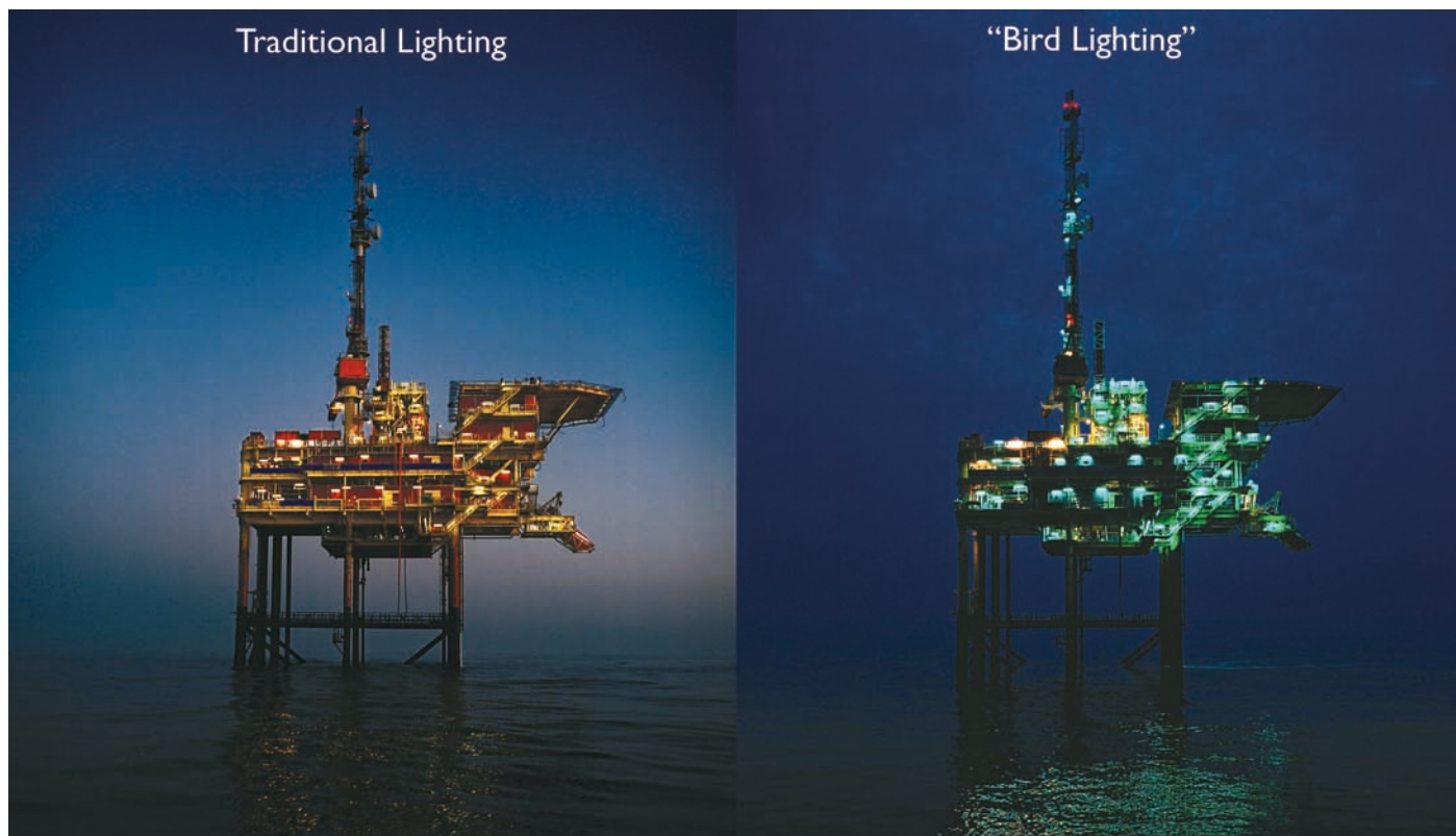
Fuglevennlig belysning av oljeplattform. Undersøkelser utført i Nederland har funnet at grønt lys gir vesentlig lavere tiltrekning av fugler enn tradisjonell belysning i gult og rødt. Kilde: www.philips.com
