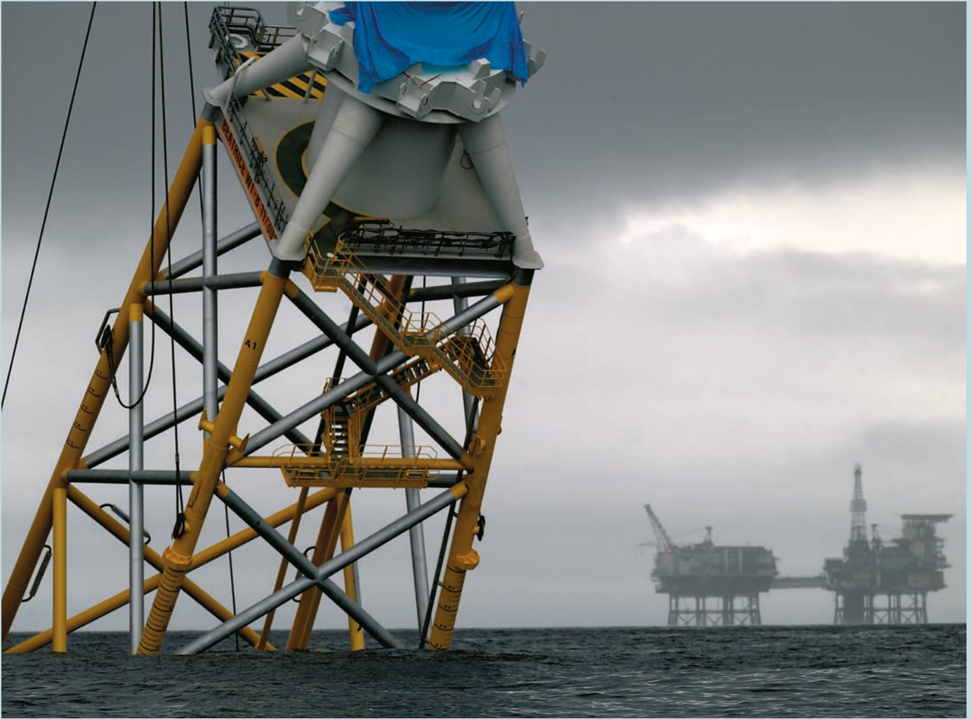
Et OWEC Tower-designet stålunderstell under installasjon på Beatrice-feltet i Skottland. Kilde: Talisman Energy/OWEC Tower.
