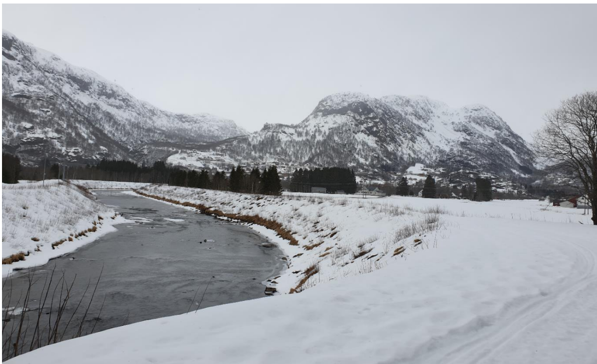
Figur 2-25 Elva er lagt i kunstig kanal på grunn av erosjonsproblematikk i innløpet til Røldal. Det er bygget terskler i elveløpet. Foto: Hydro.
