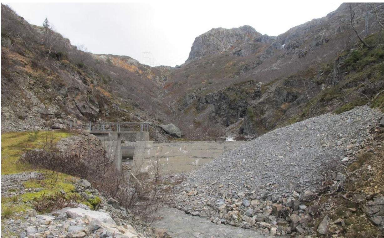
Figur 2-77 Det må laget en plan for hva man gjør med renskemasser ved inntak i Havrevassjuvet
