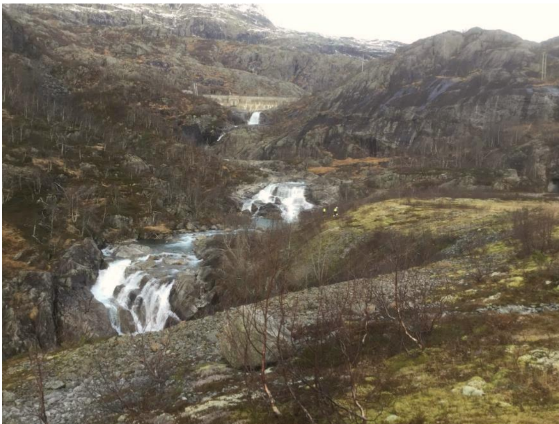
Figur 2-38 Kvanndalsfossen ved stor vannføring. Dammen i bakgrunnen og tipp i forgrunnen.
