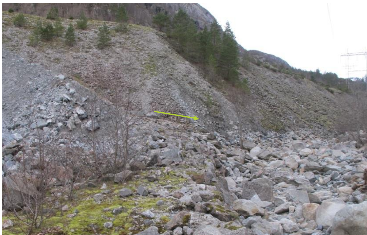
Figur 2-74 Erosjon i tipp Engjaland på grunn av for bratte skråninger.
