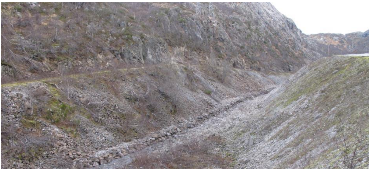
Figur 2-80 Havrevassjuvet. Den gamle anleggsveien på venstre side av bildet. Der revevegeteringen av veibanen er godt i gang med skjermende vegetasjon i forkant, er det ikke anbefalt å gjøre ytterligere tiltak for å fjerne veien.
