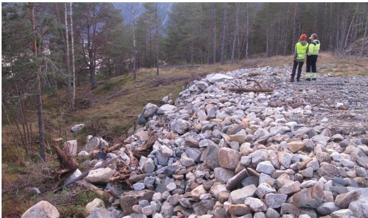
Figur 2-73 Hydros tipper bør lukkes. Massene på gamle tipper bør arronderes og tildekkes med toppmasser.
