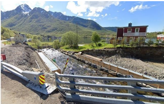
Figur 9. Erosjonssikring av Fiskfjordelva i forbindelse med etablering av ny bru, 2019. (Skjermdump fra Google maps).
