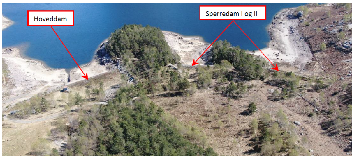
Figur 4: Dam Urdalsvatn. Dronefoto fra luftsiden. (Civil Consulting).
