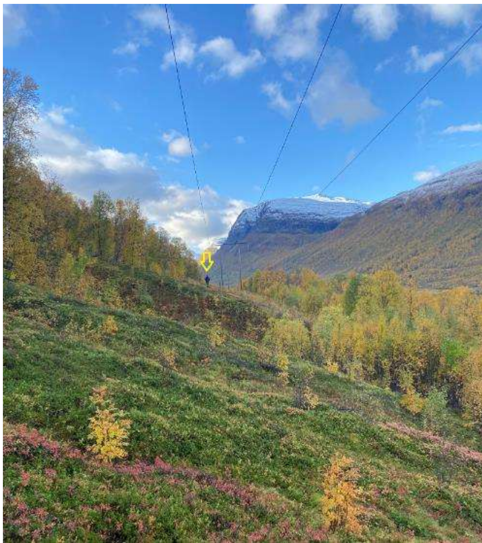
Spenn 168-169 mot mast 169
