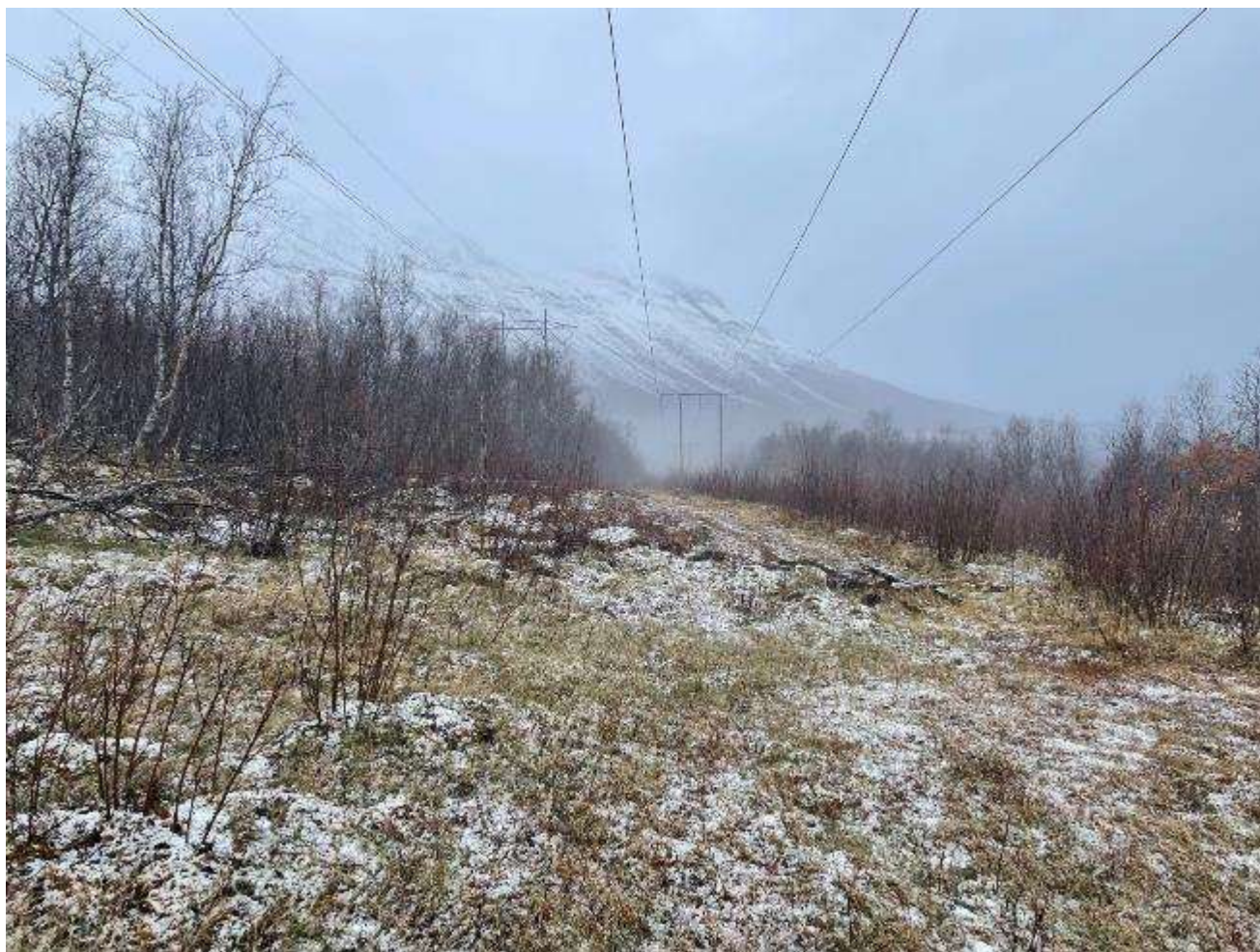
Spenn 109-110 mot mast 110
