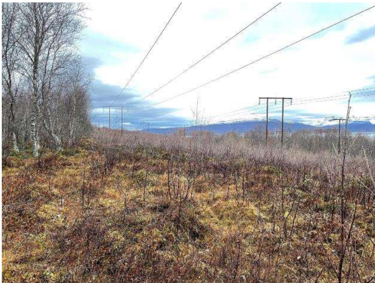
Spenn 298-299 mot mast 299
