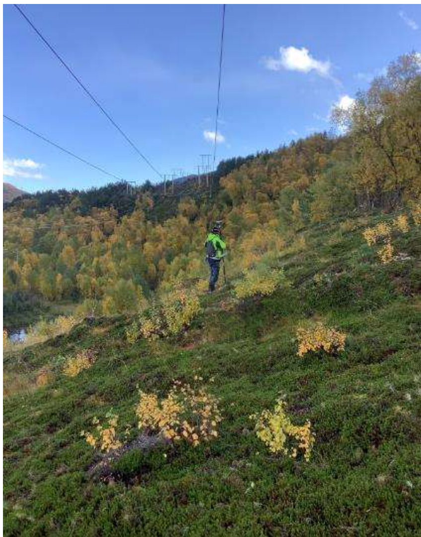
Spenn 4-5 mot mast 5
