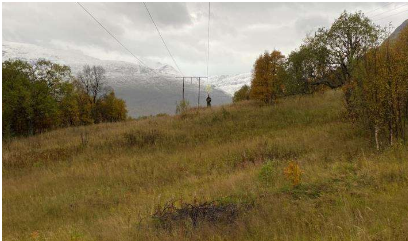
Spenn 195-196 mot mast 196
