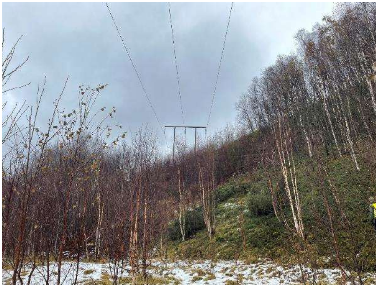
Spenn 241-242 mot mast 242
