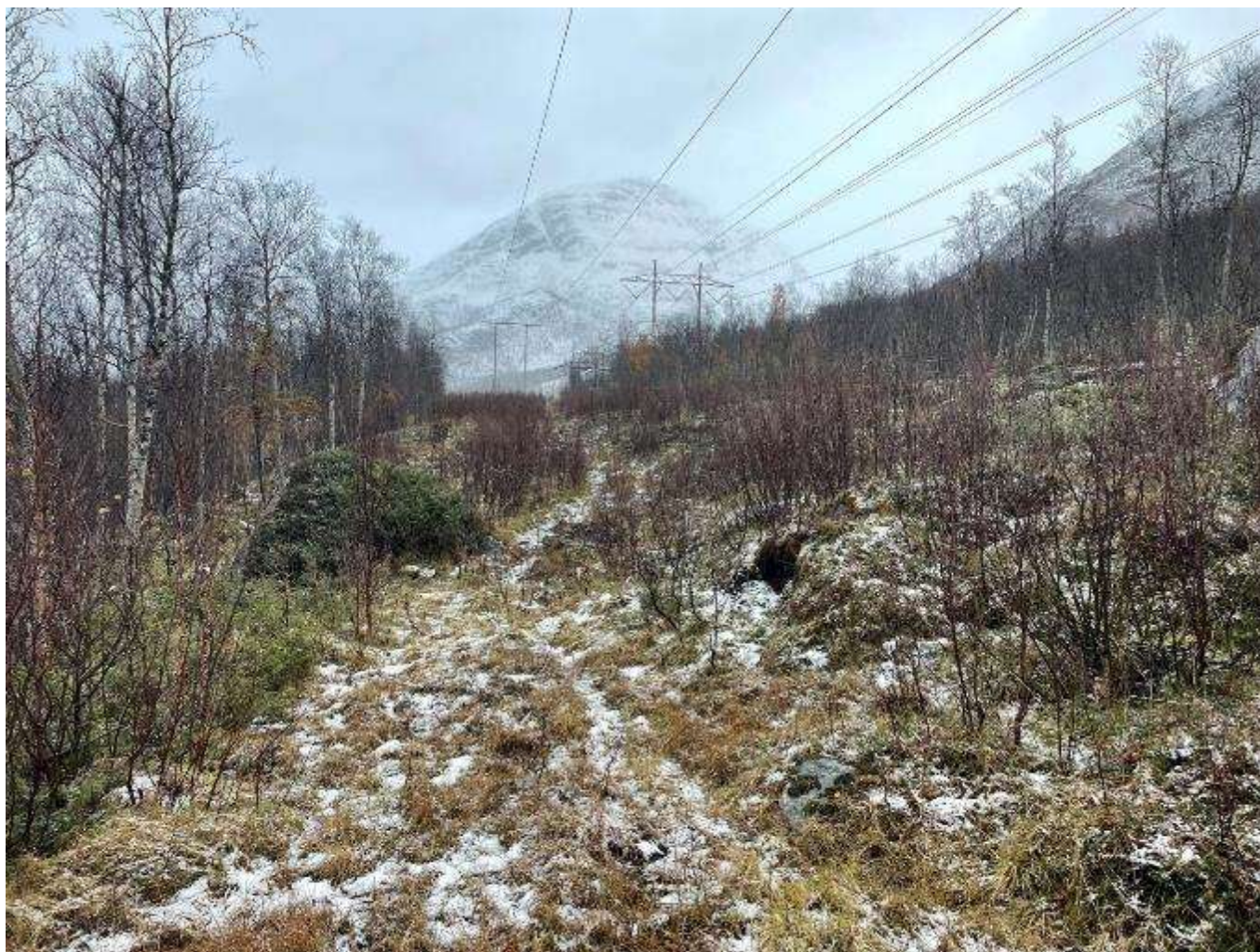
Spenn 106-107 mot mast 106
