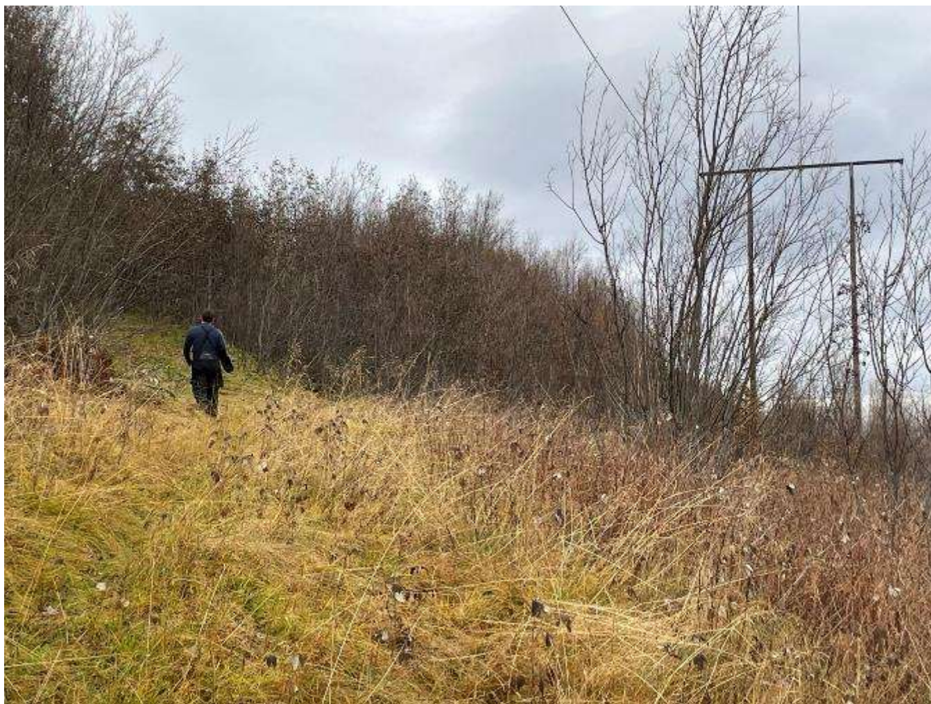
Spenn 305-306 mot mast 306
