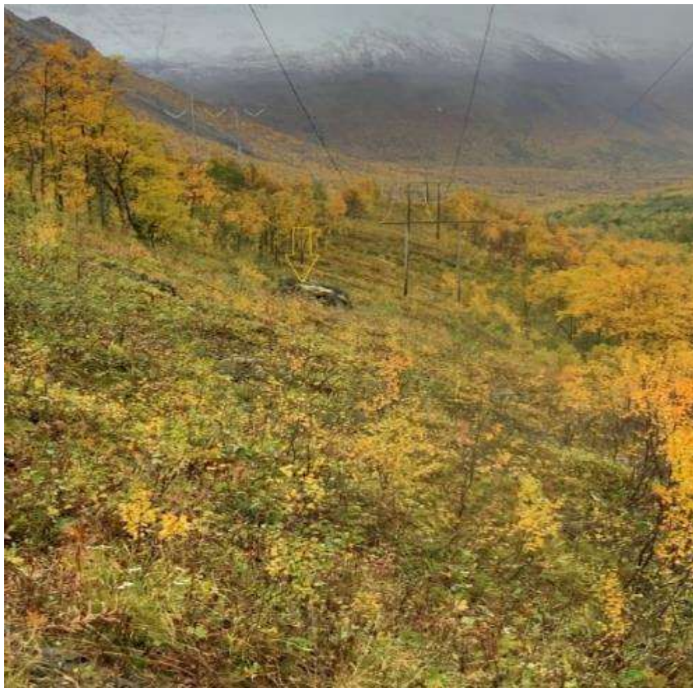
Spenn 92-93 mot mast 93
