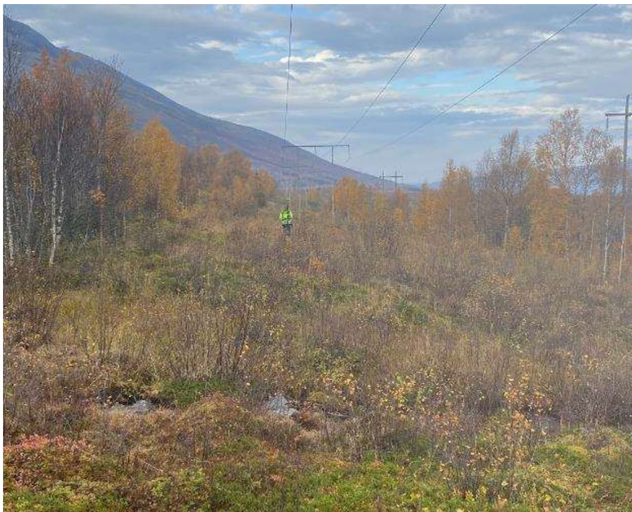
Spenn 275-276 mot mast 276
