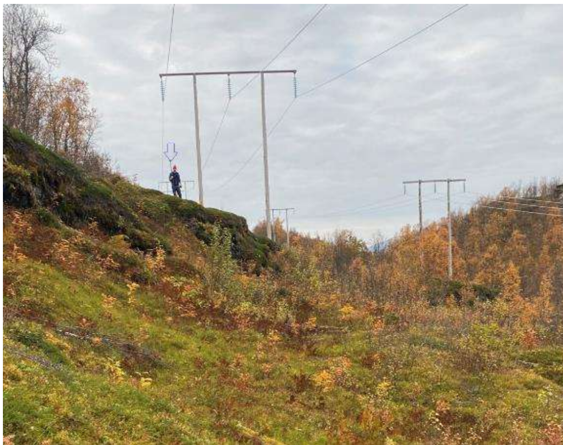
Spenn 316-317 mot mast 317
