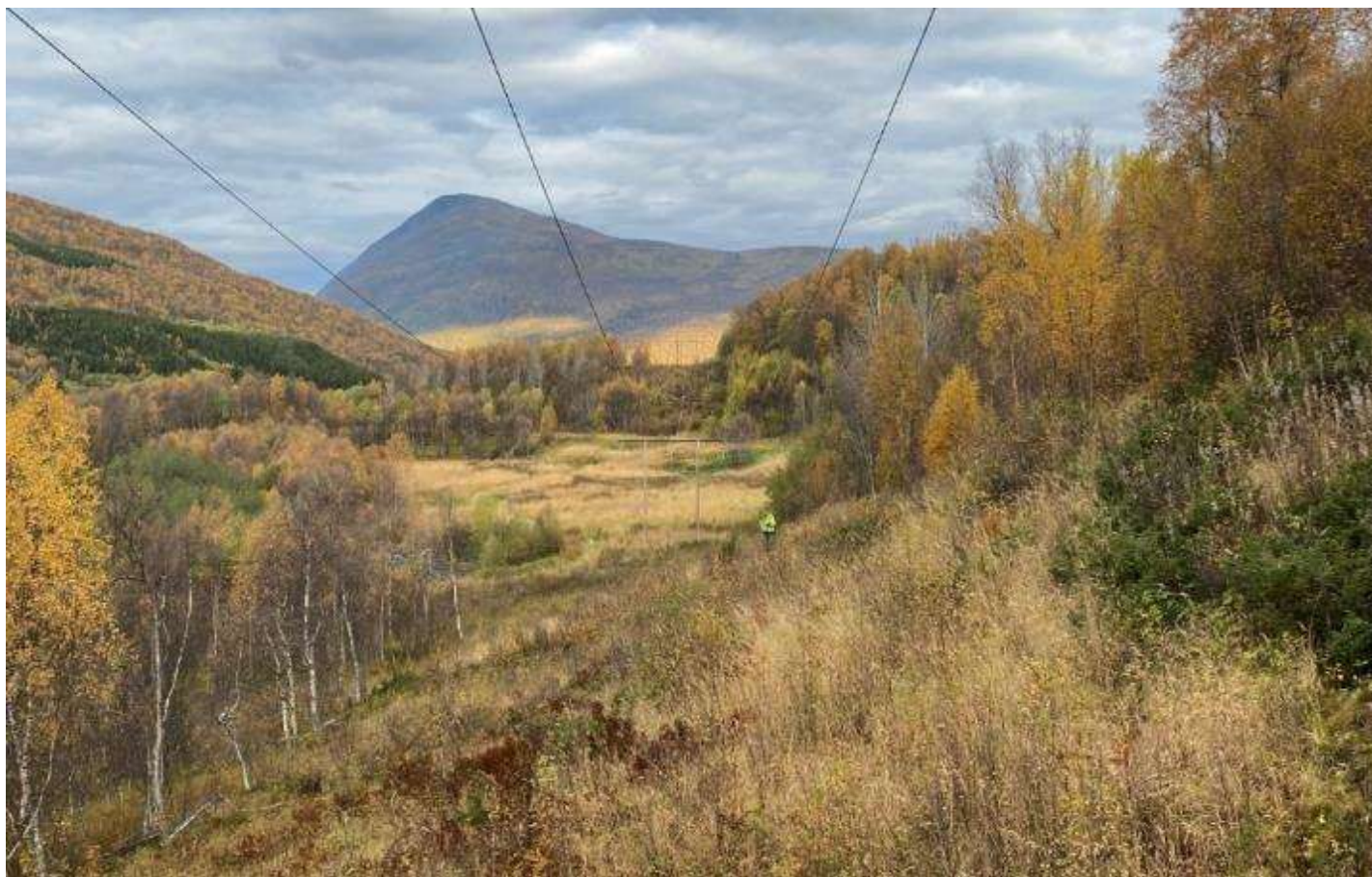
Spenn 240-241 mot mast 241
