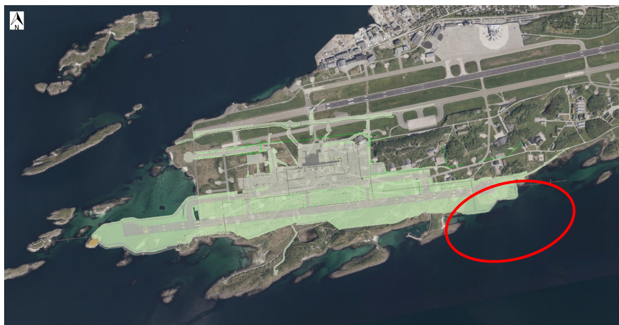
Figur 4-4. Oversikt over prosjektområdet, med rød markering av område der det er påtruffet sprøbruddmateriale.
