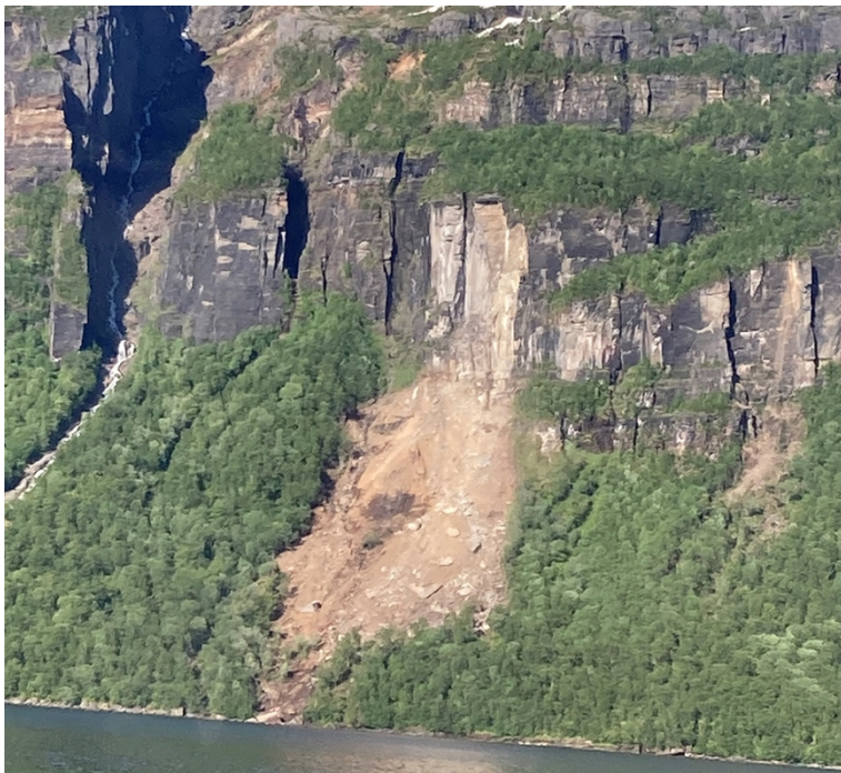
Bilde 2 Bilde som viser ett stort ras midt i bildet, og et mindre ras til høyre. Begge rasene er av nyere dato. Bilde fra 2024
