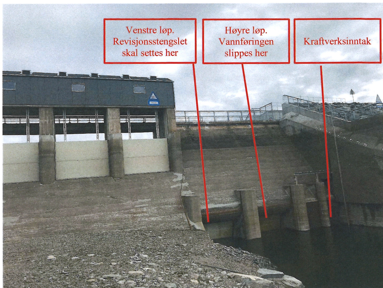
Dam Tisleifjord. Bunnløp og kraftverksinntak. Bilde tatt 19/5-2022 vannstand 0,7m over LRV, og nær vannstand når stengslet skal settes.
