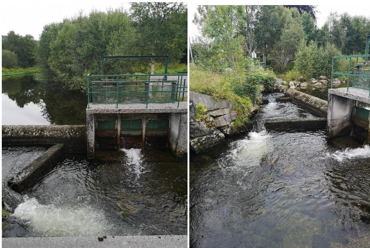
Figur 1-6 Dam Lillevatn. Bildet til venstre viser lukene, og bildet til høyre viser fiskepassasjen.
