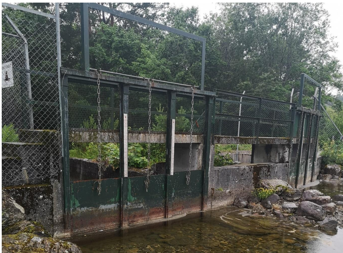
Figur 1-4 Dagens dam Brusdalsvatnet med til sammen seks luker og en fiskepassasje.
