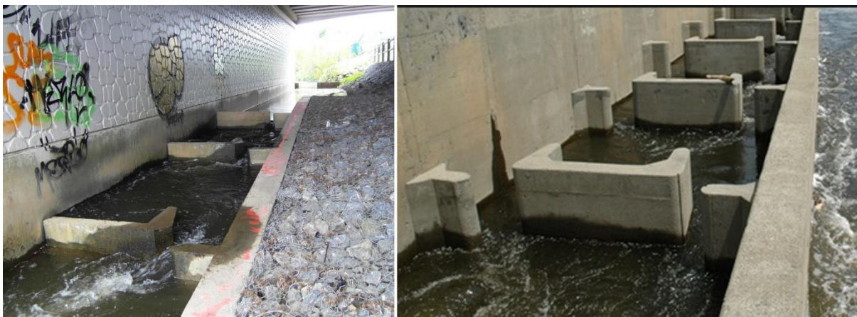
Figur 24. Illustrasjonsfoto av vertikal spaltetrapp med én (t.v.) eller to (t.h.) spalteåpninger.
