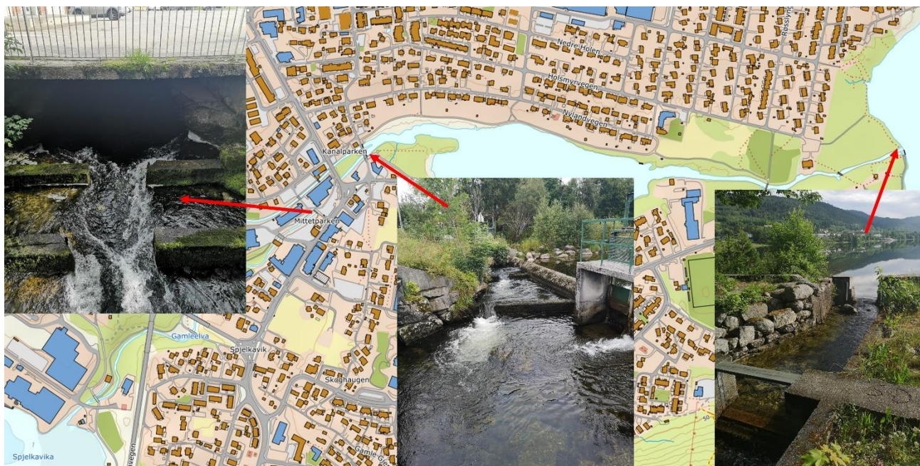
Figur 1. Fiskepassasjer/tiltak for fiskevandring ved menneskeskapte vandringsbarrierer i Spjelkavikelva.
