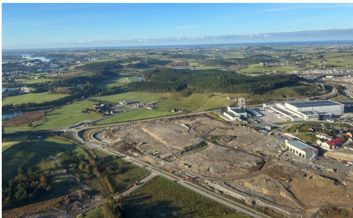
Figur 17 Anleggsarbeid på næringsområdet på Vagle september 2023.
