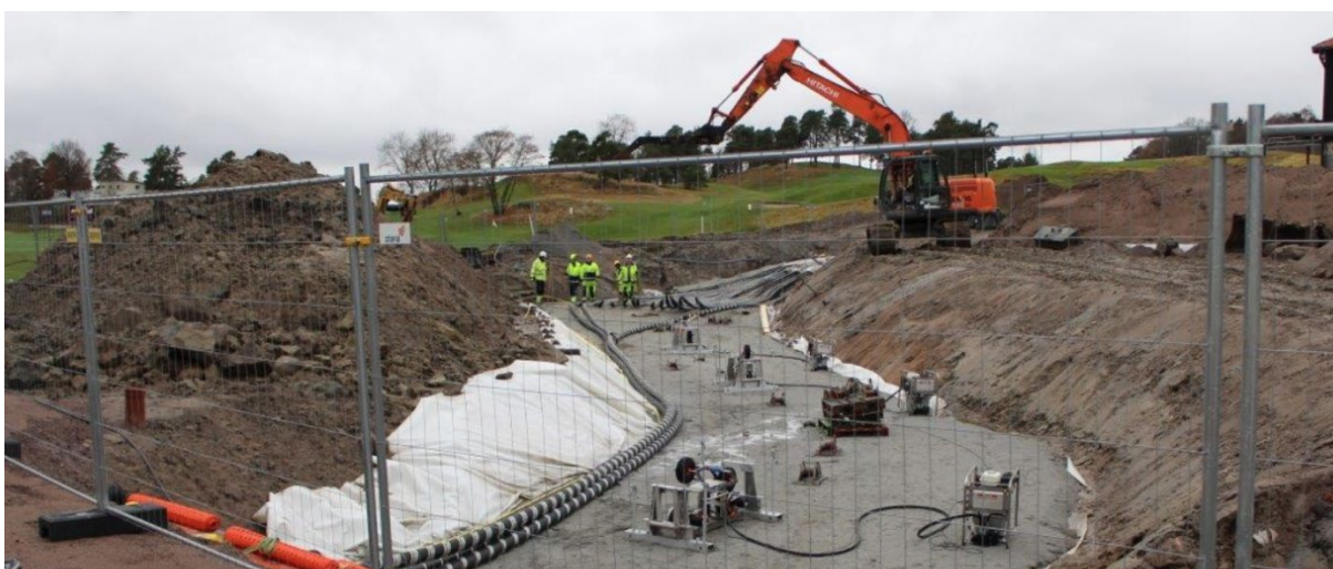
Figur 13 Typisk bilde fra kabelleggingen.
