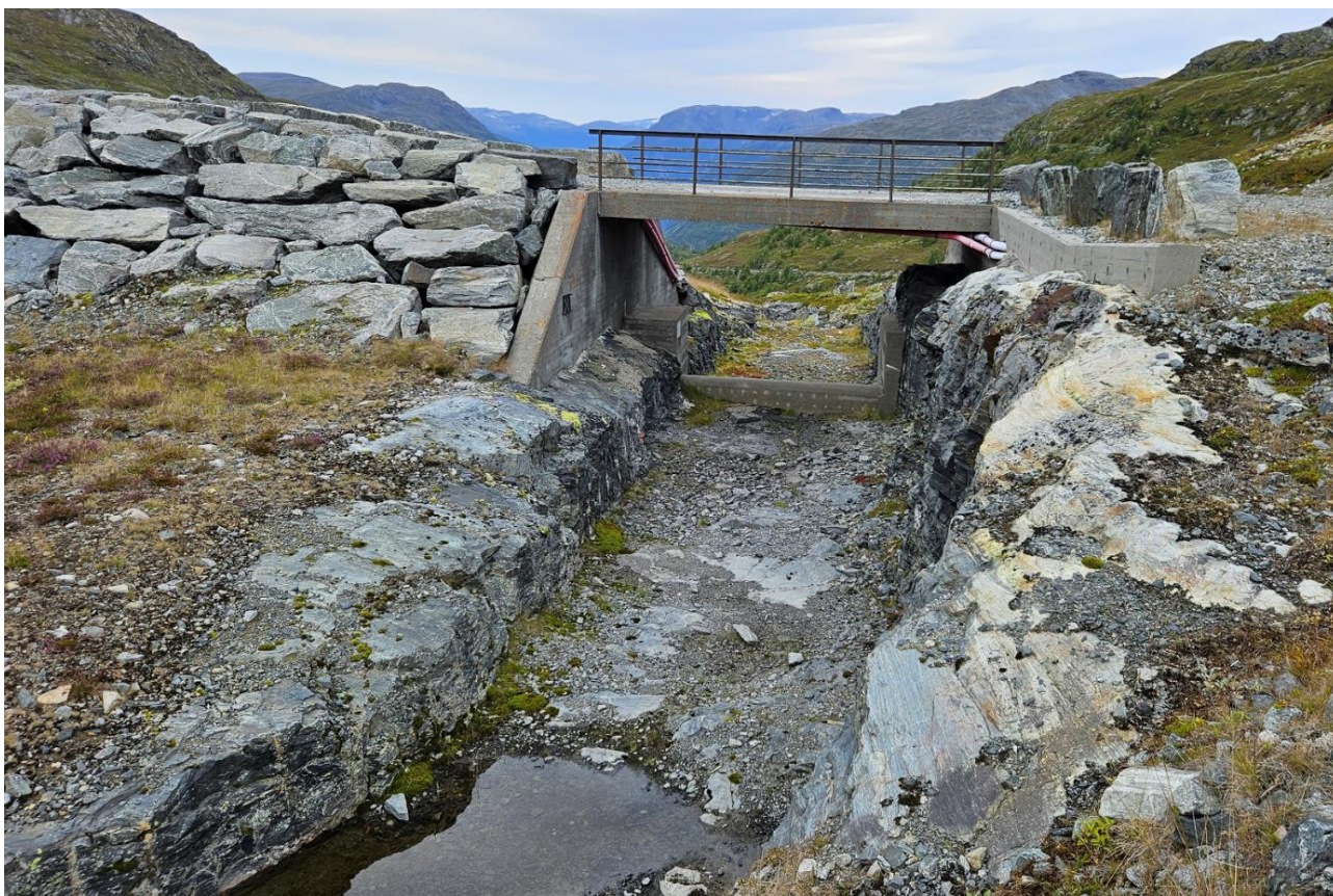
Figur 3 Eksisterende overløp på Vassetvatnet. Her har det ikke gått vann over dammen i de siste 31 årene.
