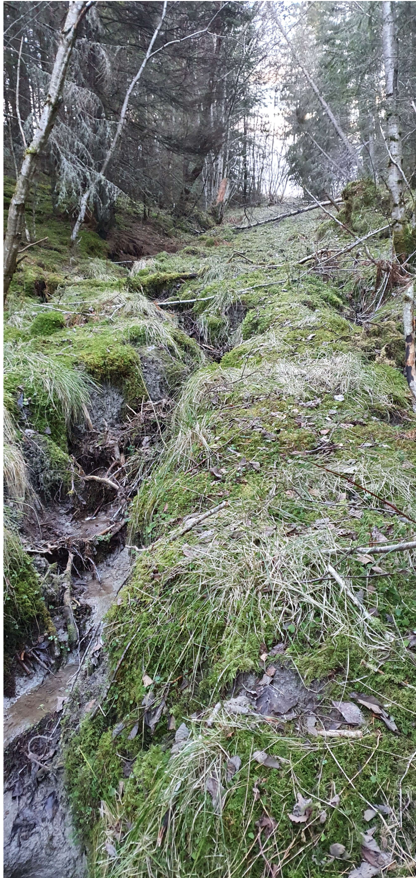
Figur 12: Bekken har erodert seg noe ned i jordmassene. Synlig leire kan ses i bunnen av bekken. Ingen glidninger ble observert i bekkedalen.
