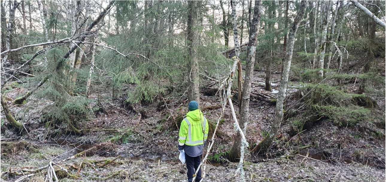
Figur 10: Synlig kant etter en tidligere overflateglidning/grunnbrudd. Personen på bildet er til sammenligning 180 cm. Også her synlig svai i trær samt flere trær som henger utover bekkedalen som indikerer sig i jordmassene.
