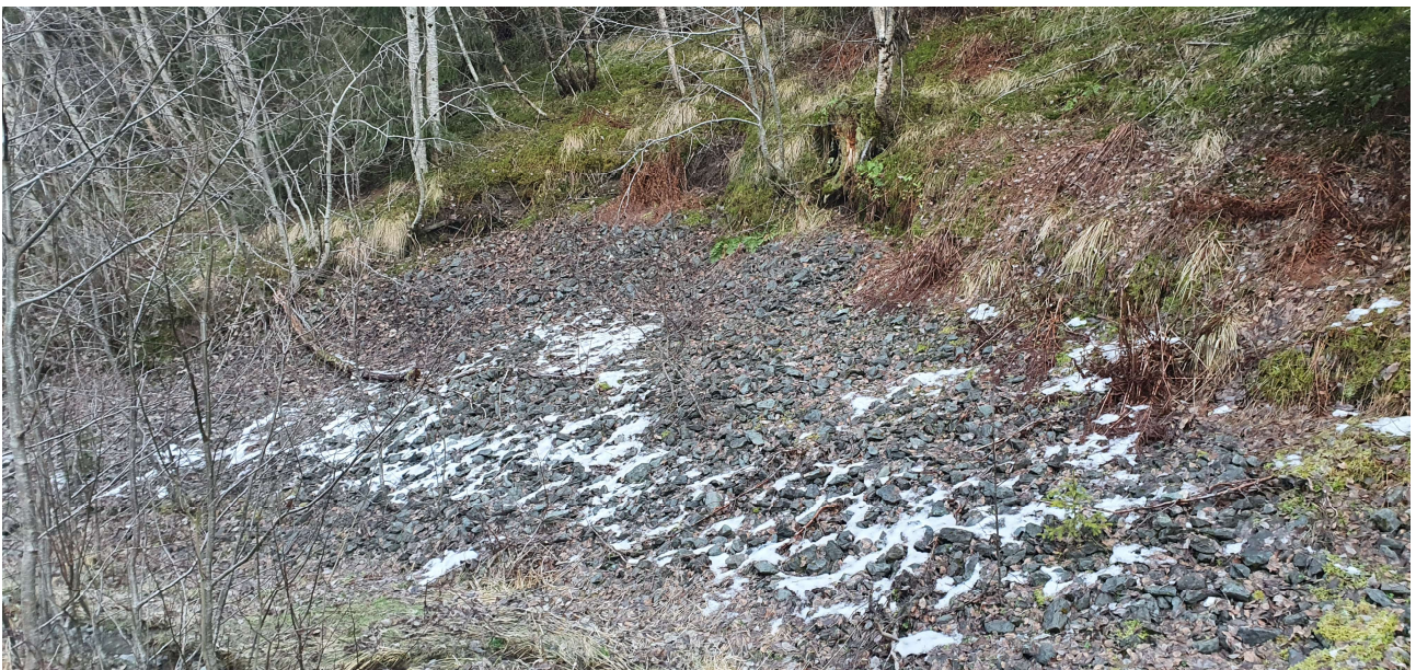
Figur 16: Tidligere overflateglidning som er erosjonssikret.
