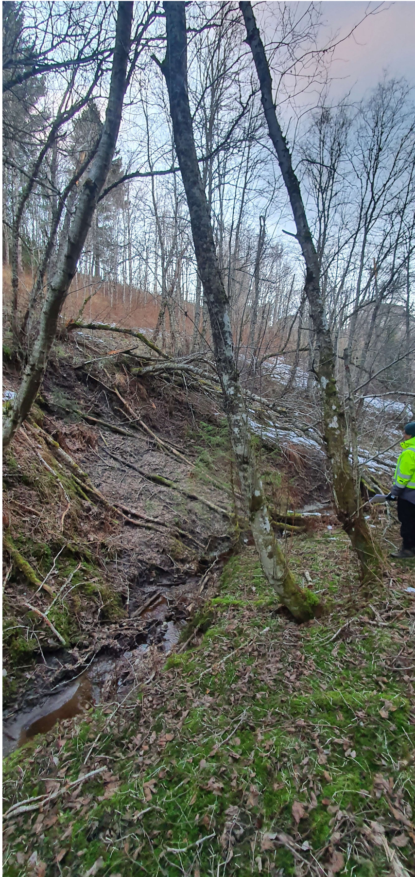
Figur 6: Arr etter en større overflateglidning i bekkedalen. Personen på bildet er til sammenligning 180 cm høy.
