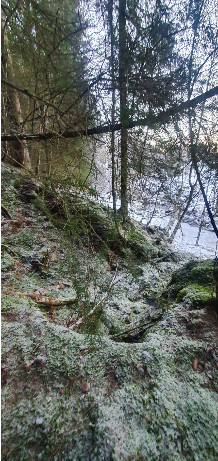
Figur 21: Skredgrop etter et mindre rotasjonsskred langs Holemsbekken.
