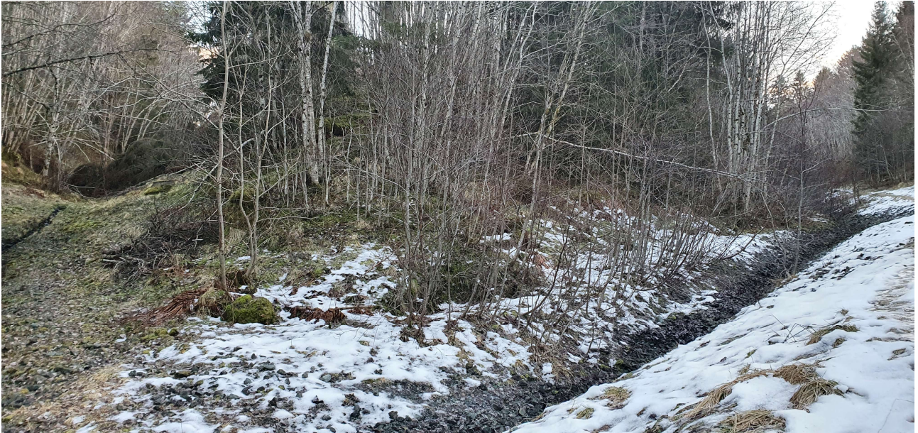
Figur 15: Begge bekkeløpene er erosjonssikret. Ikke synlige tegn til sig i massene.
